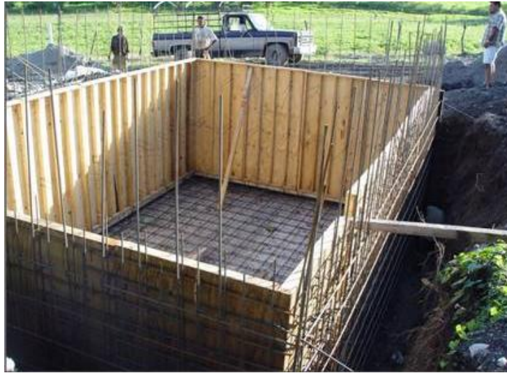
Figura 5.8 Cisterna de concreto armado hecho en obra
