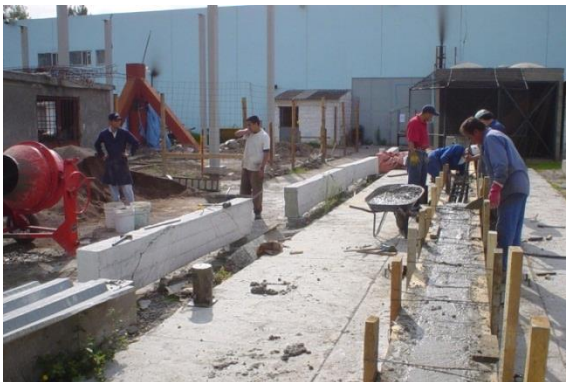
e) colocación del concreto
