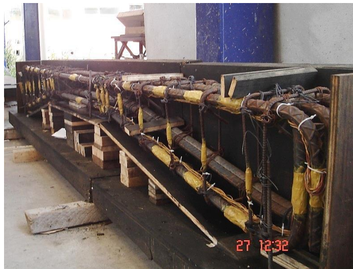
f) elementos totalmente instrumentado antes del colado
