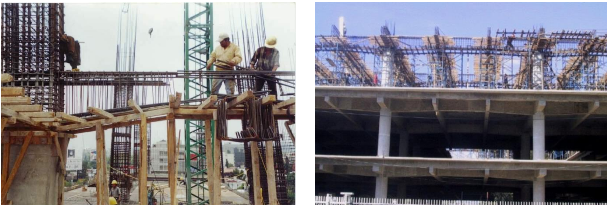
Figura 2.1 Construcción de traves acarteladas en dos edificios diferentes de la ciudad de México
