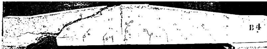
Figura 3.34 Falla en trabe sin estribos con canto acartelado superior (Stefanou 1983)
