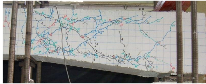
a) original (falla)
