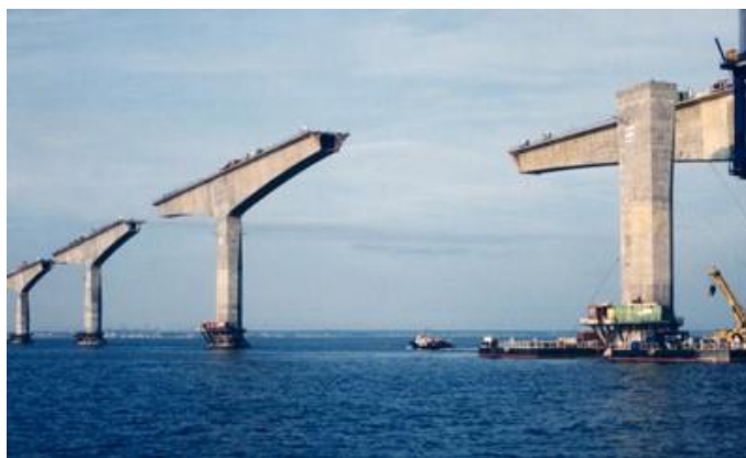
Figura 3.54 Puente Confederación en etapa constructiva (Buckland y Taylor 2011)
