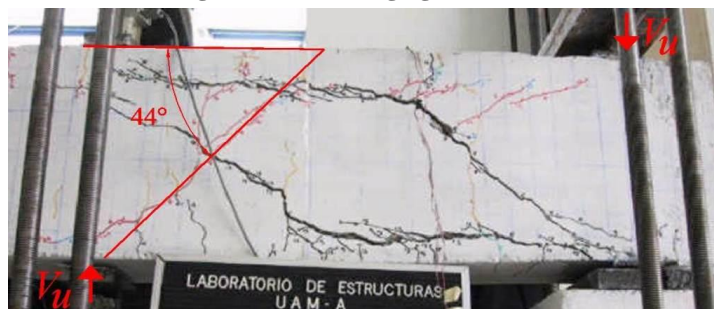
c) grieta crítica carga antigravitacional
