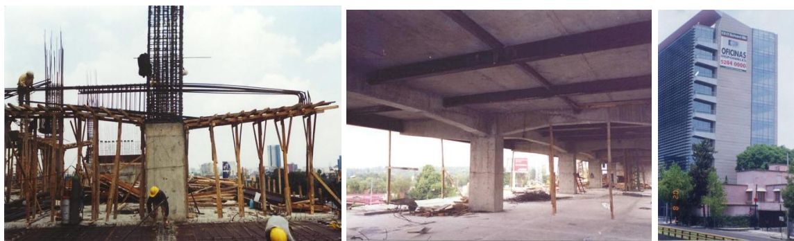
Figura 3.1 Edificio moderno de la ciudad de México con traves acarteladas
