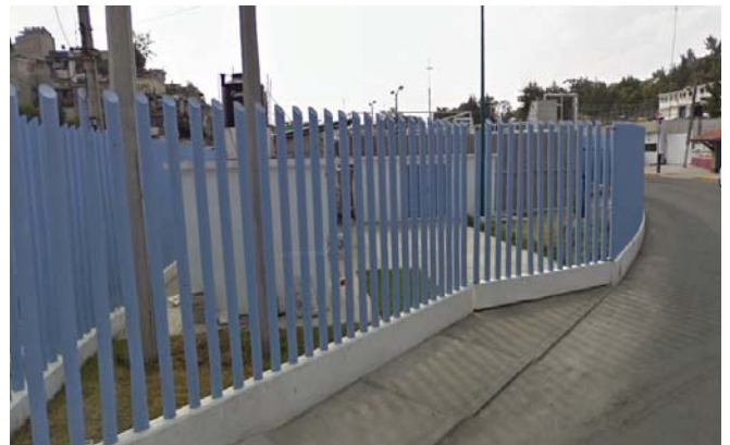
Planta Tratamiento de aguas negras, Av. de las Granjas y Av. Revolución
