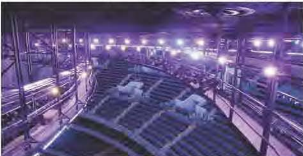
Fig. 2.33 Pasos de gato e instalaciones de iluminación sobre plafones.
