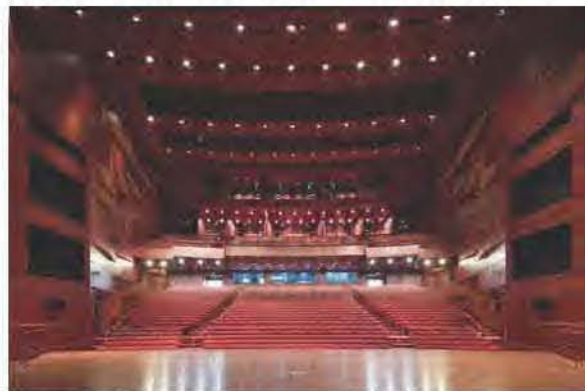
Fig. 2.14 Vista frontal de las graderías del teatro.
