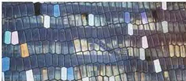
Fig. 2.3 Fachada de vidrio y acero Harpa Concert Hall
