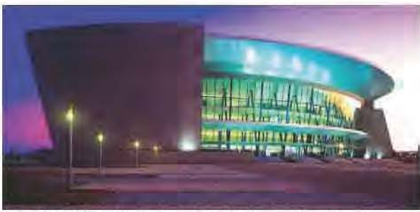
Fig. 2.31 Vista de la fachada principal del auditorio.
