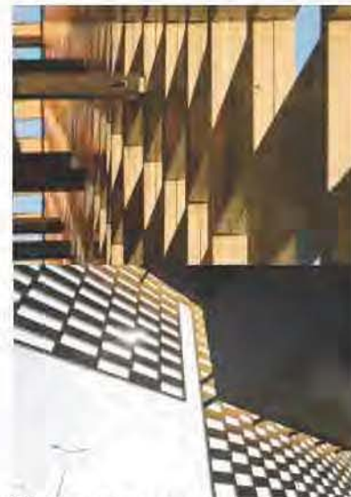
Fig. 14.7 Imagen conceptual segunda piel acústica del recinto de conciertos que funciona como aislante acústico y como control de iluminación.
