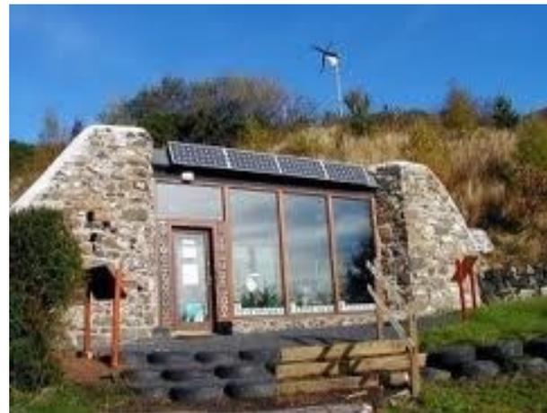
Nuevo México, "Earthship" Casa hecha con Llantas y botellas de vidrio, utilizando paneles solares y aprovechando la capacidad de absorción térmica de los materiales y principios de arquitectura bioclimática.
