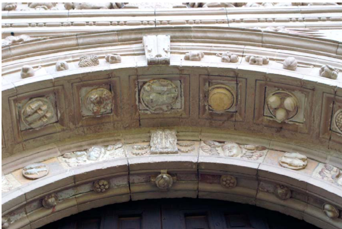
Fig. 57 Se pueden observar restos de color en algunas partes como en el intradós del arco, donde algunas de las viandas representadas todavía tienen algo de la pintura utilizada originalmente.
