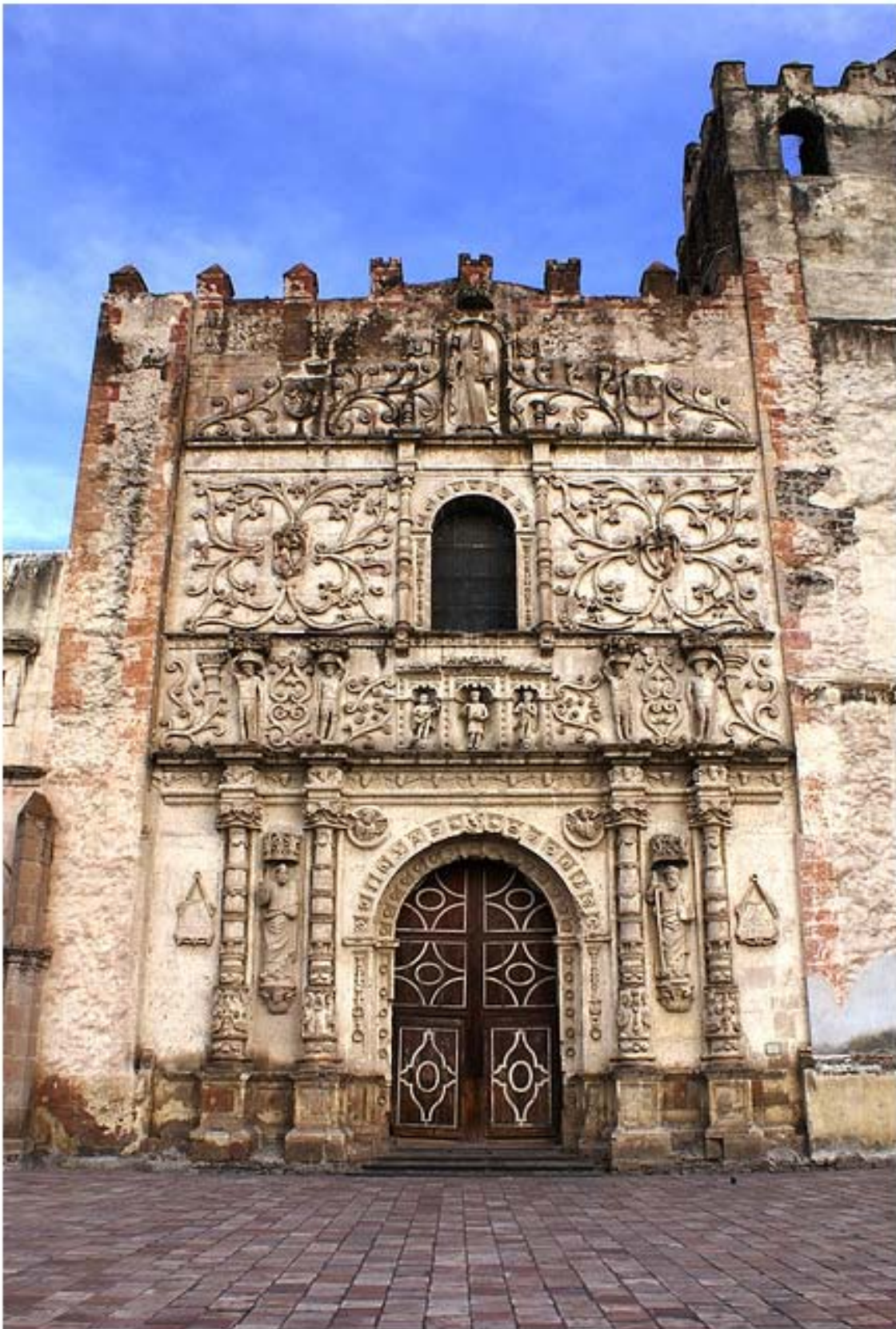
Fig. 28 Plateresco en la Nueva España. Portada de San Agustín de Yuriripúndaro, Guanajuato, México.
