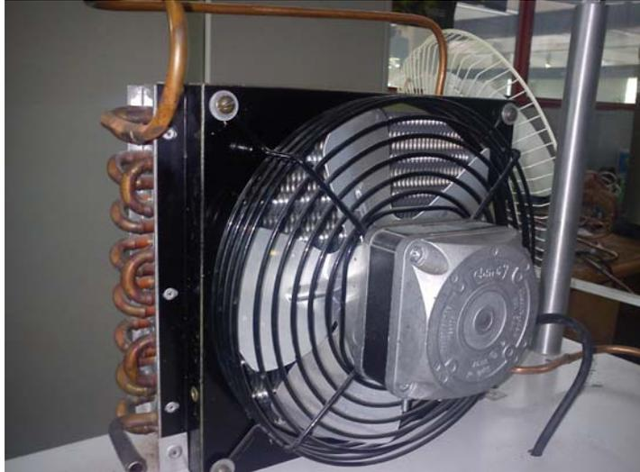
Figura 15. Condensador.
