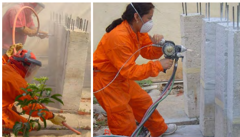
Figura 27. Limpieza con chorro de arena y aplicación del rociado térmico de Zinc.
