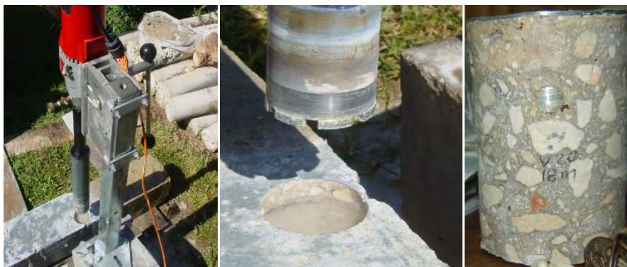
Figura 32. Proceso de extracción de corazón del concreto armado.
