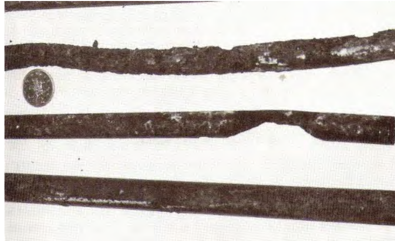
Figura 8. Refuerzo envuelto a todo lo largo con una membrana impermeable. Sujetos a bajo contenido de oxígeno y por consiguiente presenta un consumo local del acero con crecimiento de óxido no expansivo.
