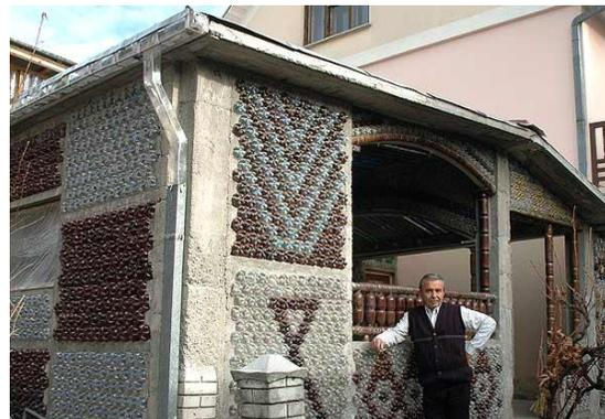
Se ha generado otra manera de construir utilizando las botellas, la gran diferencia es que las botellas se colocan vacías de modo vertical. El sistema constructivo inició en Sudamérica, consiste en acomodar las botellas vacías una sobre la otra unidas por la misma cara, dentro de un entramado doble hecho de materiales biodegradables o malla de gallinero, es necesario construir una estructura independiente.
