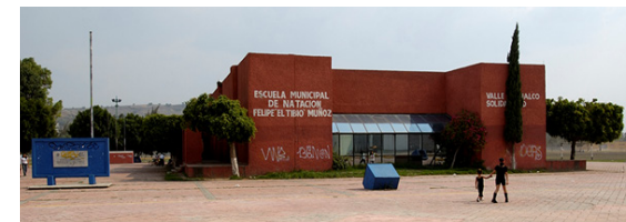
Imagen 6.4 Aquí se puede ver una fotografía de la alberca semi-olímpica en Xico II, se observa poco mantenimiento en la zona.
