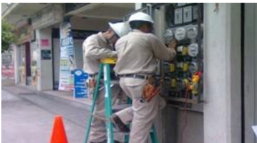
Imagen 4: Trabajadores de la CFE 4
