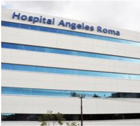
Fachada Hospital Ángeles Roma.
