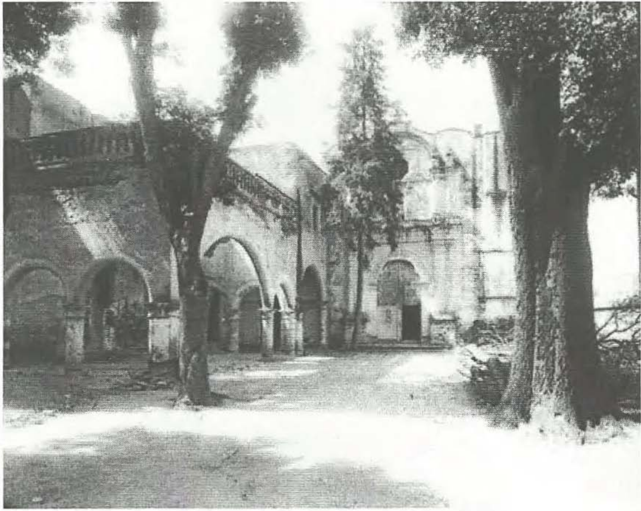
Imagen del Portal de Peregrinos y Capilla de la Tercera Orden tomada en el año 1920, donde se puede apreciar la vegetación del sitio y la falta de pavimento en el atrio, marcándose los desniveles con la propia tierra. Foto: SINAFO, Fototeca Nacional.
