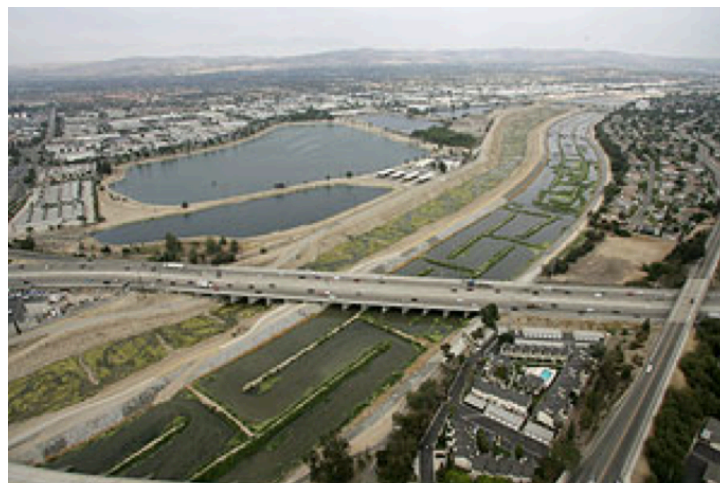
Figura 15. Imagen de un caso de modificación al canal. Fuente: (DINA-MAR 2010).
