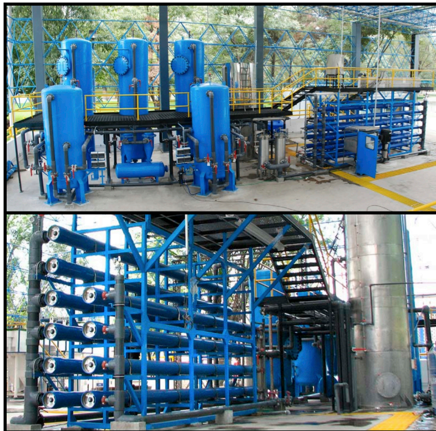
Figura 25. Tren de tratamiento avanzado y su módulo de ósmosis inversa. Fuente (SACM, 2011).
