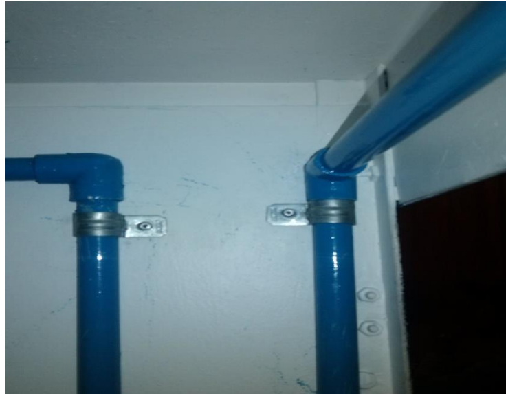
FIGURA 2.27 FOTO FIJACION DE TUBERIA.
