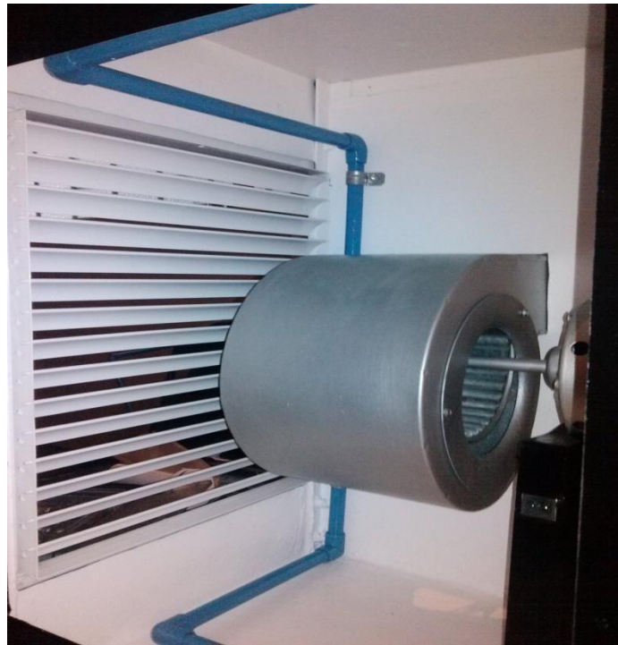
FIGURA 2.26 FOTO INSTALACIÓN HIDRAULICA.
