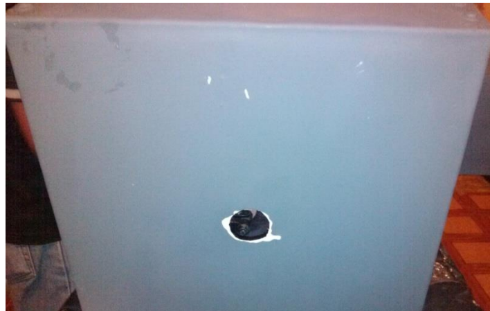
FIGURA 2.33 FOTO DE PERFORACIÓN PARA EL DESAGÜE.
