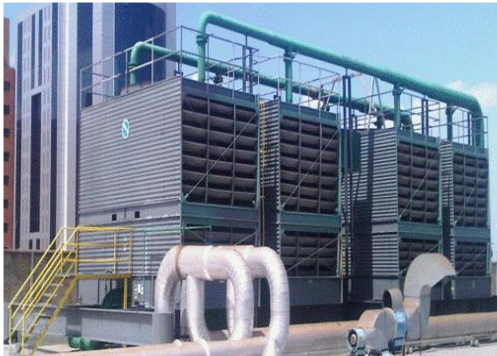
FIGURA 1.25 EJEMPLIFICACION DE TORRE DE EMFRIAMIENTO ( http://caracas.olx.com.ve/suministros-condensadores-torres-de-enfriamiento-bac-ii-266004632 ).
