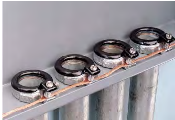
Figura 53. Accesorios para conectar canalizaciones metálicas a un conductor de puesta a tierra.
