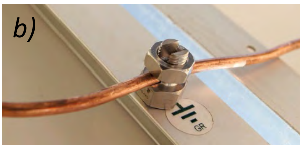
Figura 46. a) y b) Puesta a tierra de equipo. c) Caja combinadora (bornes para puesta a tierra).
