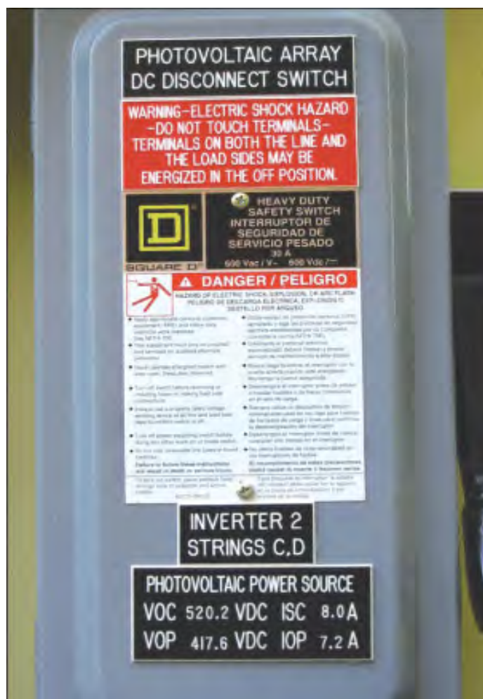
Figura 41. Ejemplo de desconectador marcado adecuadamente.
