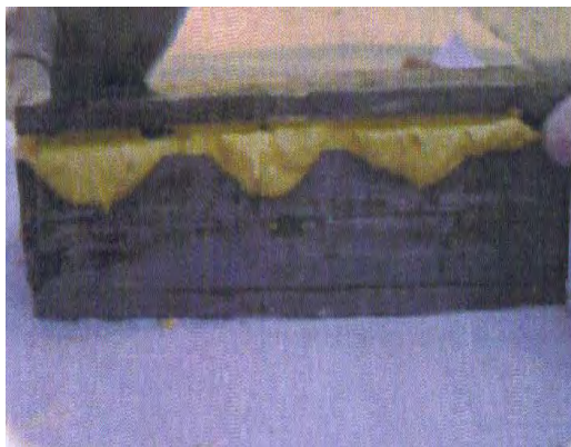
Fig. .6 Colocación de la tapa.
