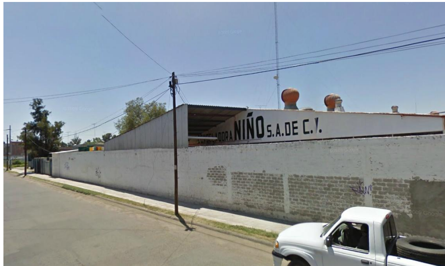
Imagen 26. Vista de una congeladora de fresas ubicada en la colonia Las Carmelitas (Fuente: Google Maps Street View, 2012).
