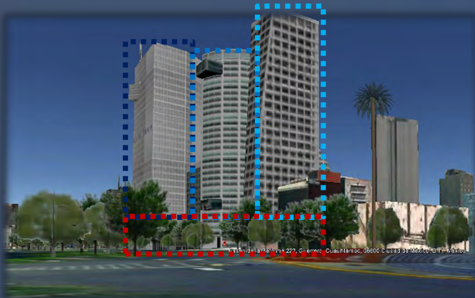
Perspectiva del conjunto Reforma 222. Fuente google maps
