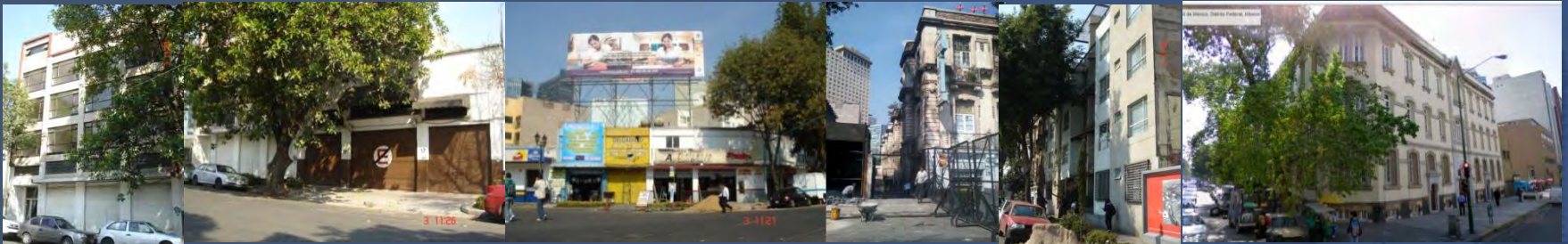
Vistas de los edificios que aun faltan por demoler y catalogados. Imágenes tomadas por el equipo.
