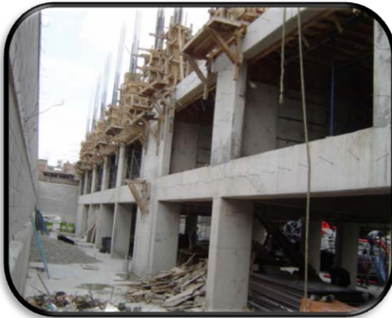
Columnas de concreto armado de .80cms x .60 cm Trabe de concreto armado con peralte de 40cms
