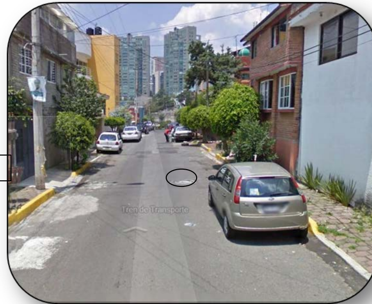
Imagen 15 vista calle y alcantarillado de la colonia I 13
