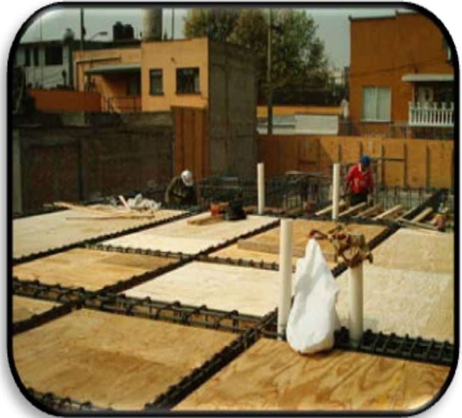
Preparación para colado de la losa de concreto armado del primer nivel de 5 construidos.
