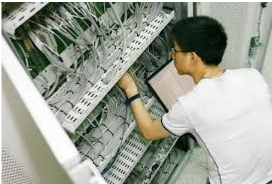
Figura 1.3.3 Mantenimiento de cableado estructurado
