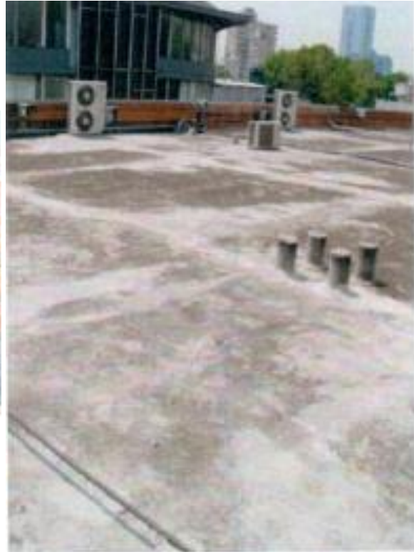
Figura 6.1.8.35 Azotea de la Universidad
