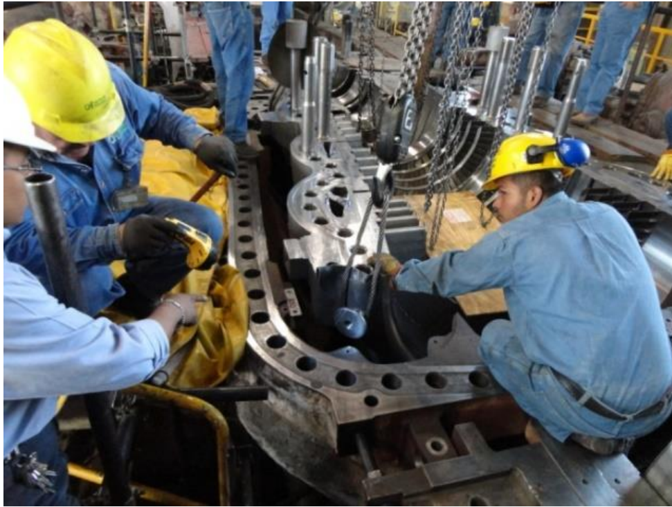
Figura 4.77 Montaje de cilindro interno inferior I.P.
