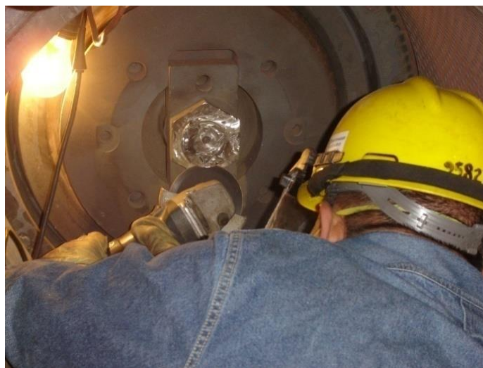
Figura 4.23 Retirando soldadura de la válvula interceptora F.
