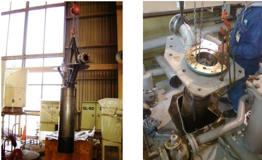
Figura 4.52 Mantenimiento general bomba auxiliar de lubricación, se cambiaron componentes dañados.
