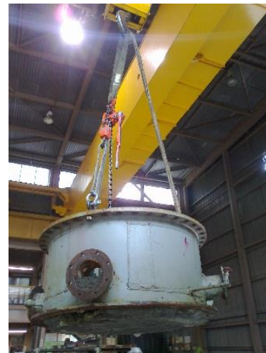
Figura 4.47 Retiro de cabezales de agua de entrada/salida enfriamiento agua de circulación.
