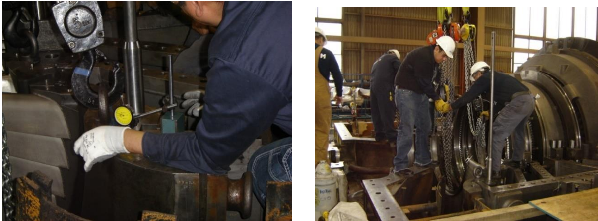
Figura 4.55 Montaje de componentes turbina de baja presión para medición y alineación.
