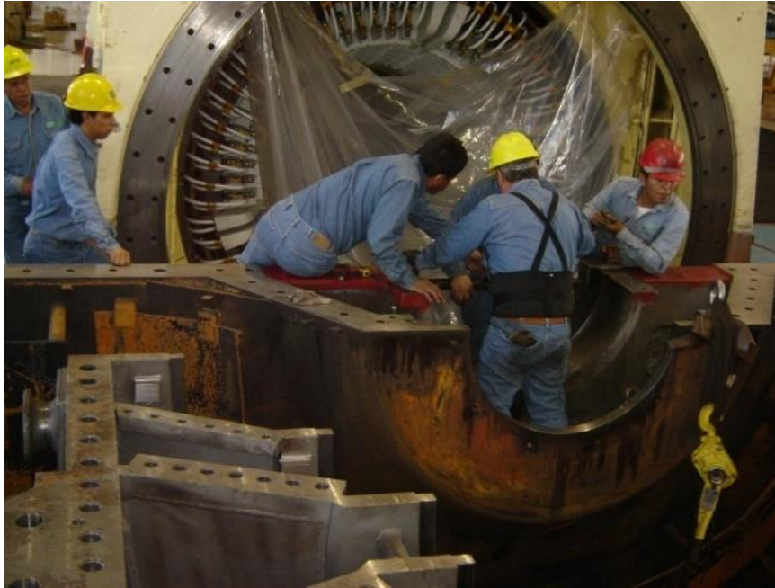
Figura 4.40 Alineación en zona de baja presión.
