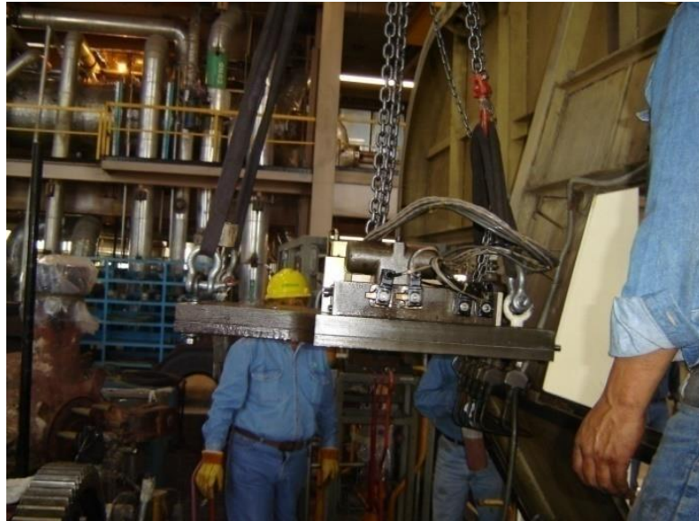
Figura 4.4 Retiro de tapa de aceite de control.
