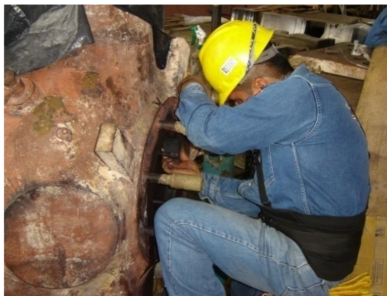
Figura 4.21 Limpieza de válvulas de paro y control.
