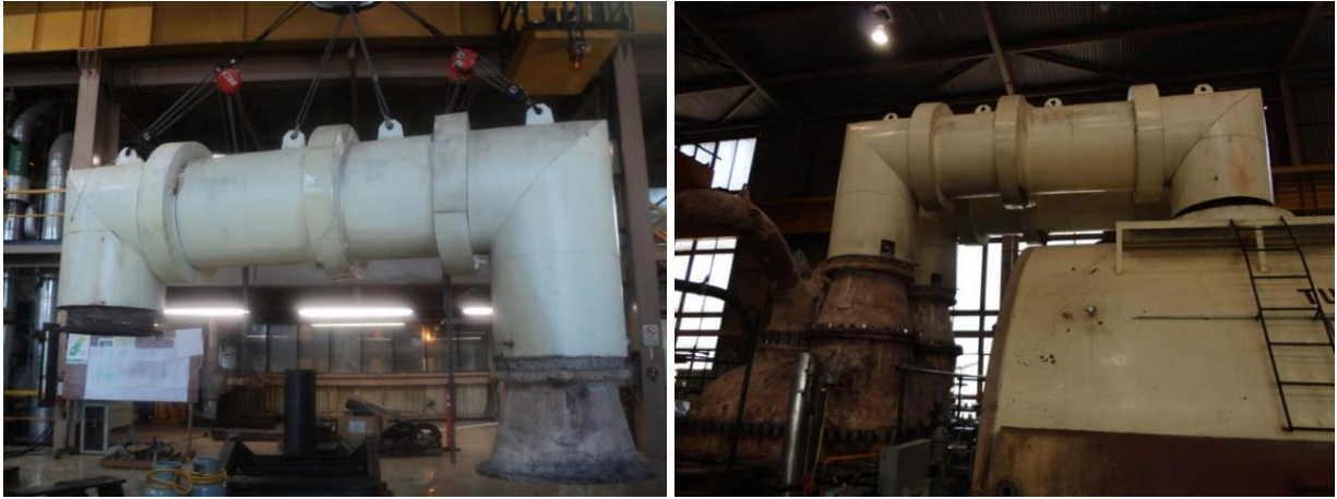
Figura 4.83 Colocación de junta en crossover
