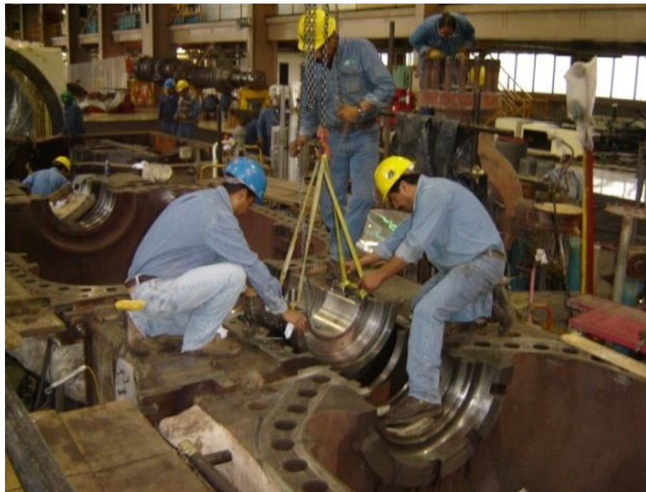
Figura 4.39 Maniobra de izaje para colocar chumacera 3.
