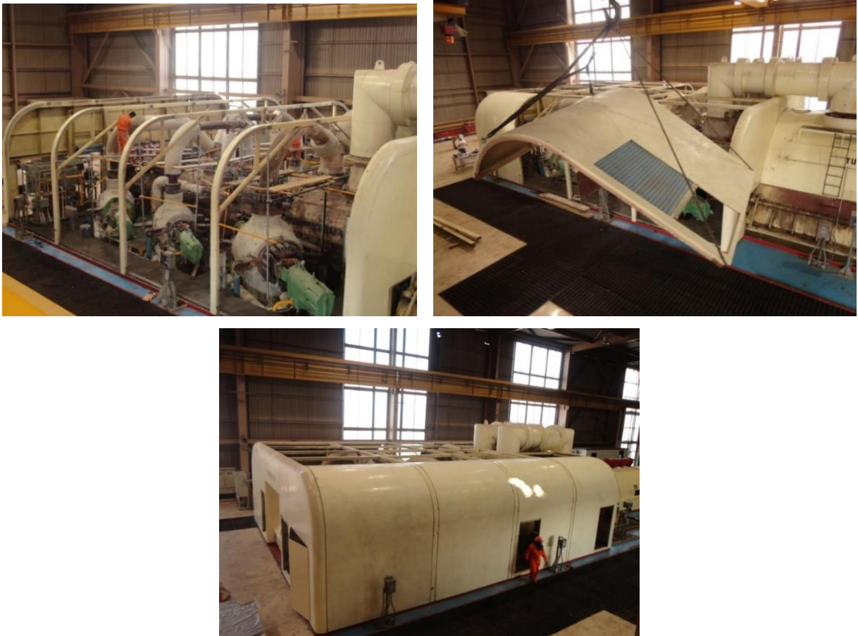
Figura 4.93 Armado de estructura de turbina.
