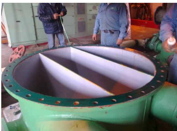
Figura 4.48 Empaque laminado para cabezal entrada agua enfriamiento a enfriadores de aceite
