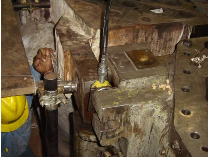
Figura 4.57 Movimiento de pedestal con porta-power.
