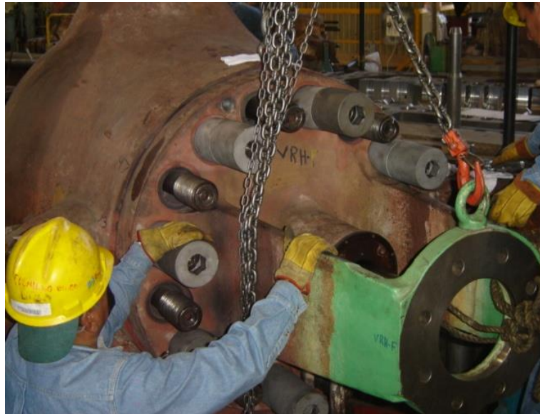
Figura 4.29 Colocación de tapa de válvula interceptora.
