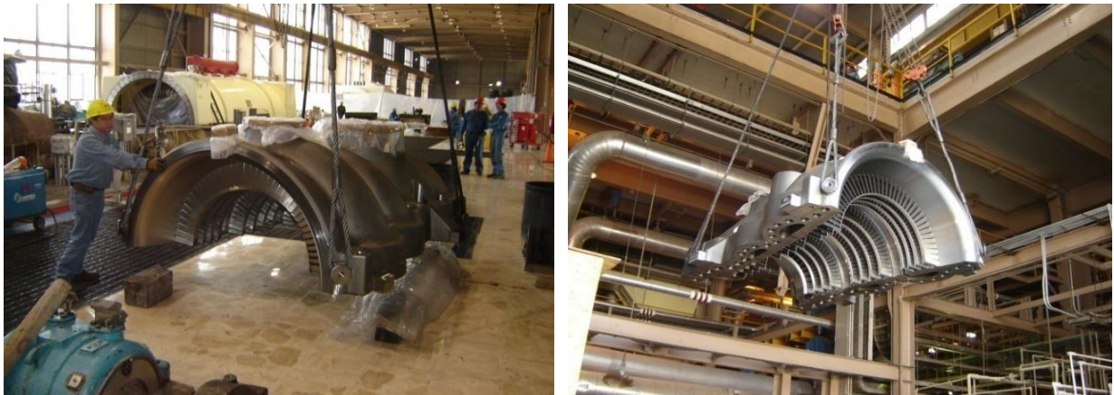
4.20 Maniobra y colocación en soporte de madera de porta alabes superior.
