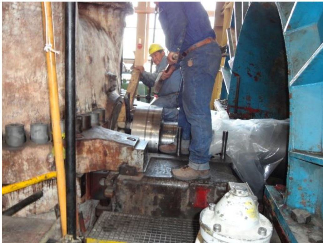
Figura 4.88 Apriete de pernos en el cople núm. 2
