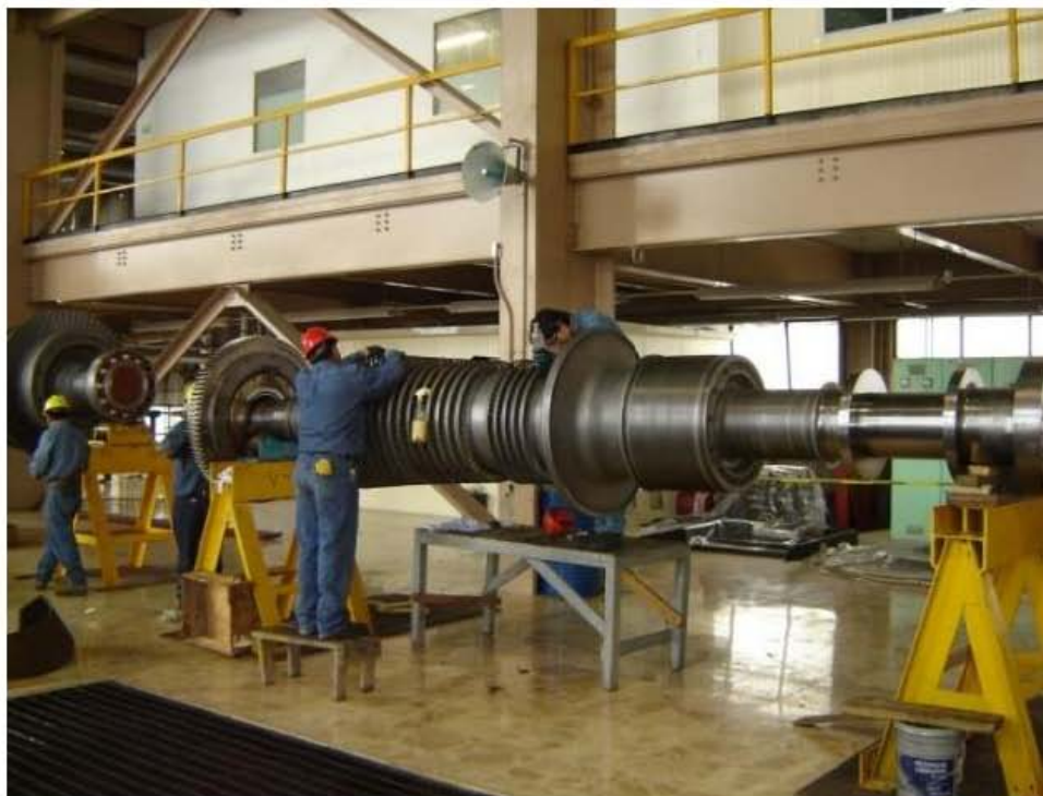
Figura 4.37 Limpiezas de los rotores de alta e intermedia presión.
