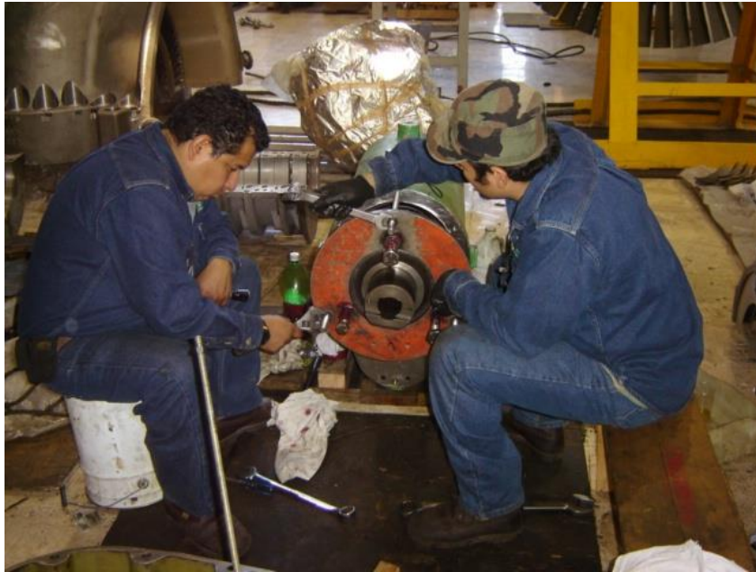
Figura 4.61 Limpieza de actuador de válvula.
