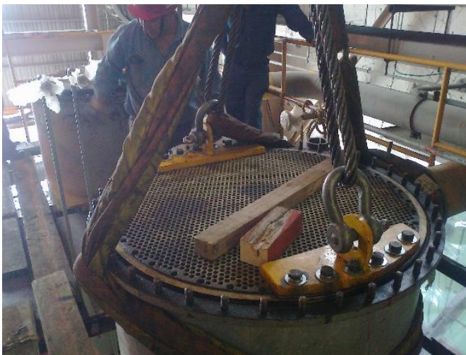
Figura 4.47 Retiro de cabezales de agua de entrada/salida enfriamiento agua de circulación.
