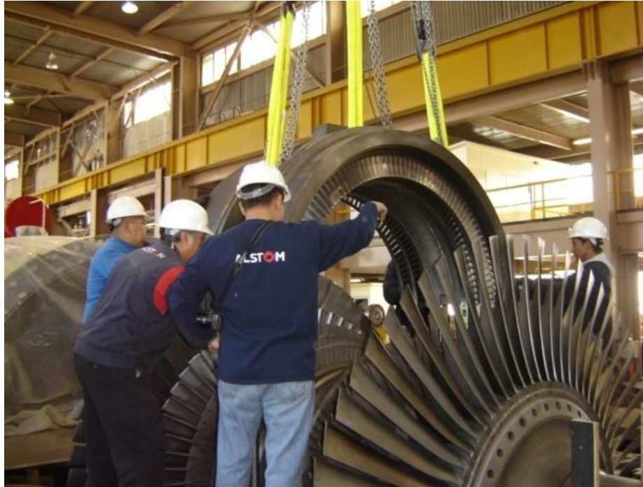
Figura 4.68 Colocación de porta alabes en rotor de baja.
