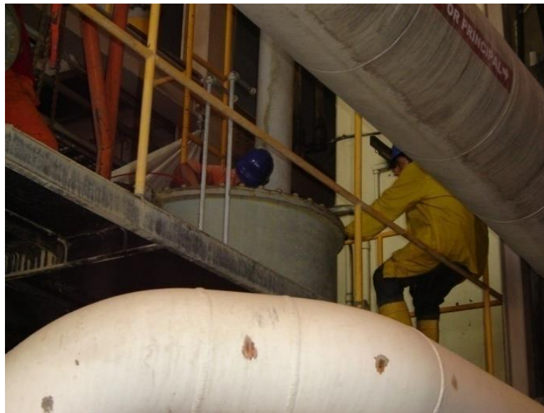
Figura 4.7 Limpieza en enfriadores de aceite.
