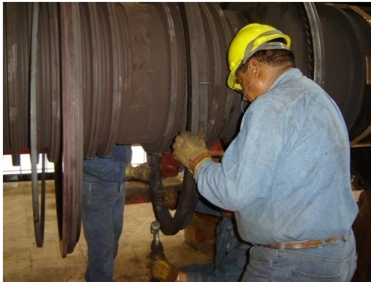
Figura 4.17 Limpieza de anillos de tobera de admisión de vapor.
