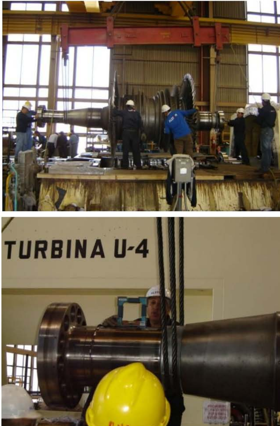
Figura 4.63 Alineación y colocación de rotor de baja.
