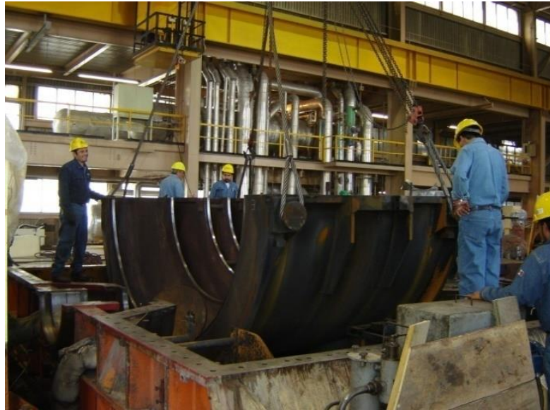
Figura 4.35 Retiro de la carcasa inferior del rotor de B.P.
