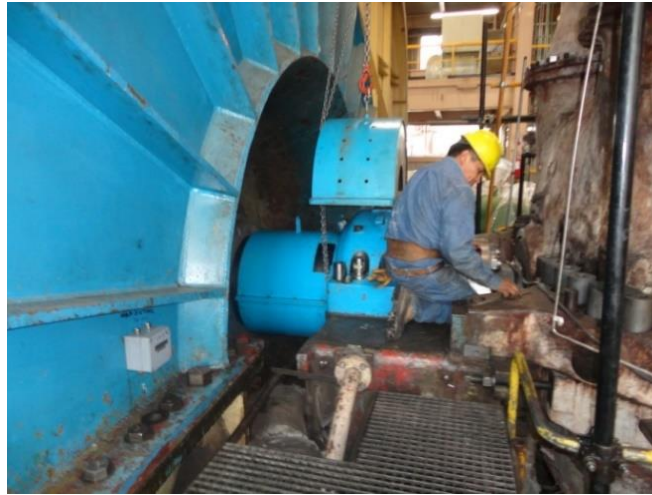
Figura 4.92 Instalación de cubre coples número 2
