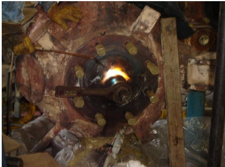
Figura 4.22 Calentamiento de la zona para retiro de tornillería.
