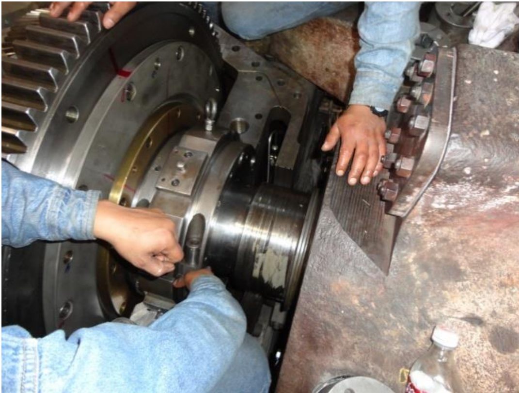
Figura 4.84 Instalación de chumacera 1 (carga)
