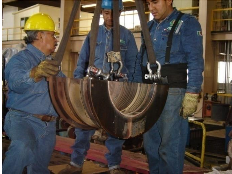
Figura 4.12 Retiro de empaquetadora de sellos de la chumacera de carga No. 2.
