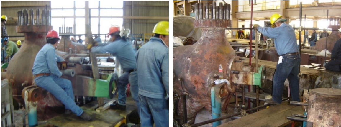
Figura 4.31 Asentando las válvulas interceptoras.
