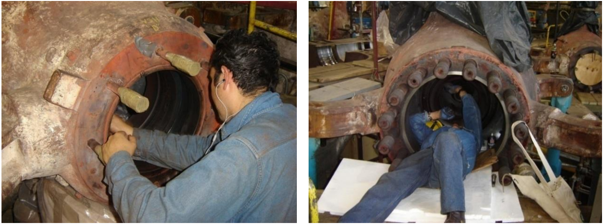
Figura 4.24 Limpieza de válvulas de paro y control.
