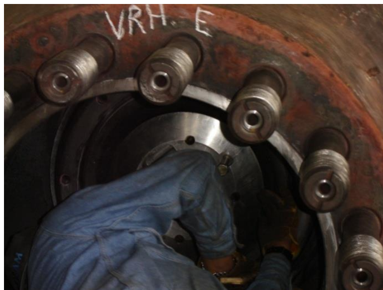
Figura 4.28 Limpieza en válvula interceptora “E”.
