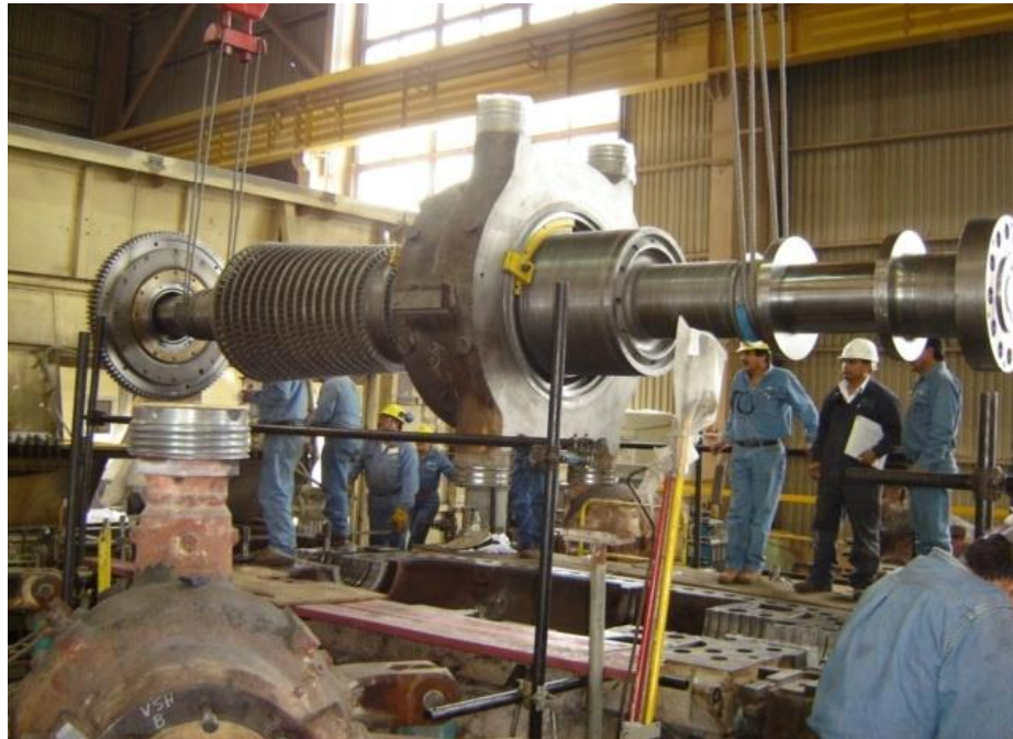
Figura 4.49 Maniobra para colocar rotor de alta.
