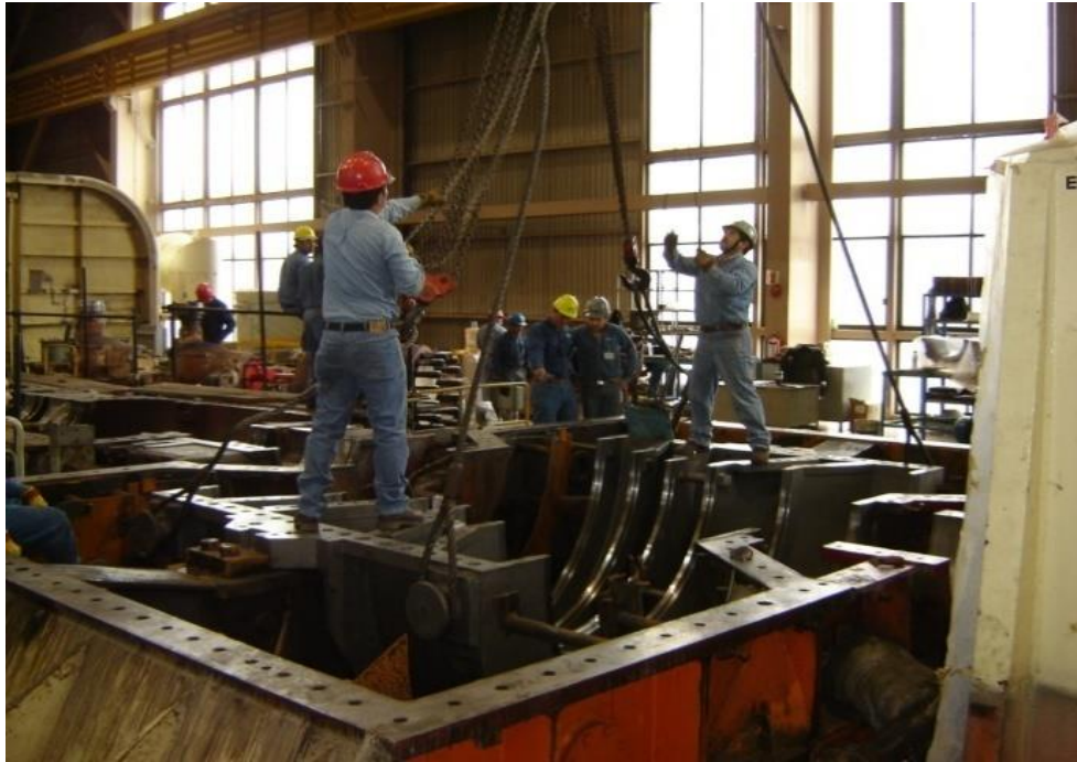
Figura 4.38 Maniobra de izaje de la carcasa inferior de rotor de baja.
