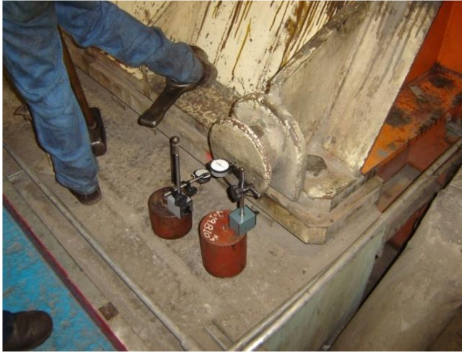
Figura 4.43 Alineación de carcasa de baja presión.
