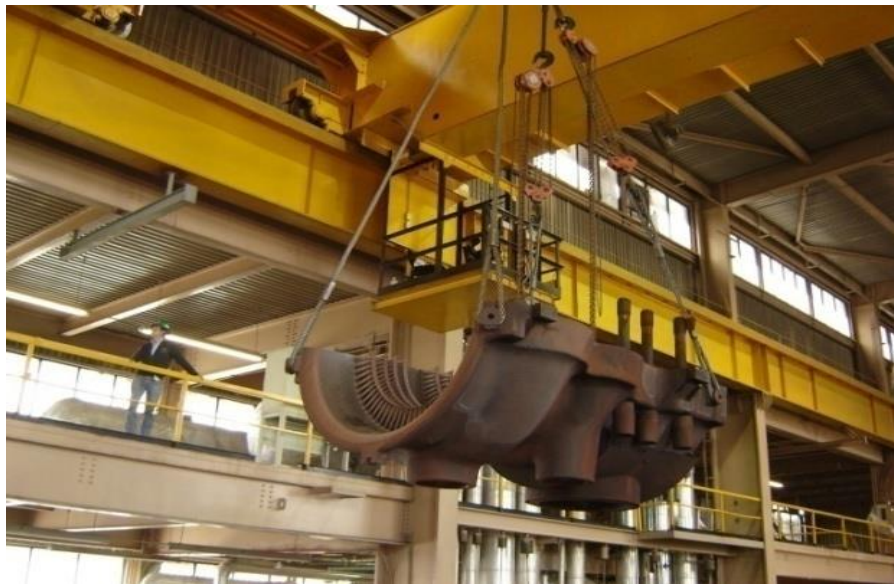
Figura 4.13 Maniobra para retiro del porta alabes inferior de rotor de presión intermedia.
