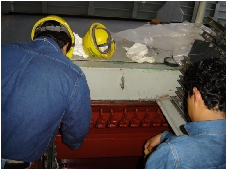
Figura 4.6 Limpieza en el interior del tanque acondicionador de aceite.
