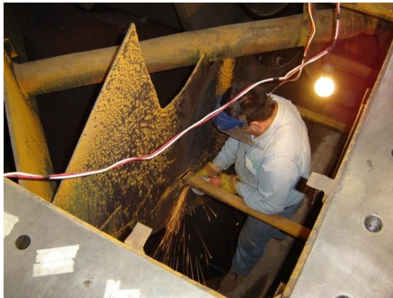
Figura 4.50 Realizando cortes en láminas para su mantenimiento.
