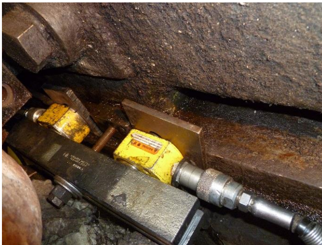
Figura 4.62 Retiro de guías axiales de pedestal chumacera núm. 2 lado gobernador.
