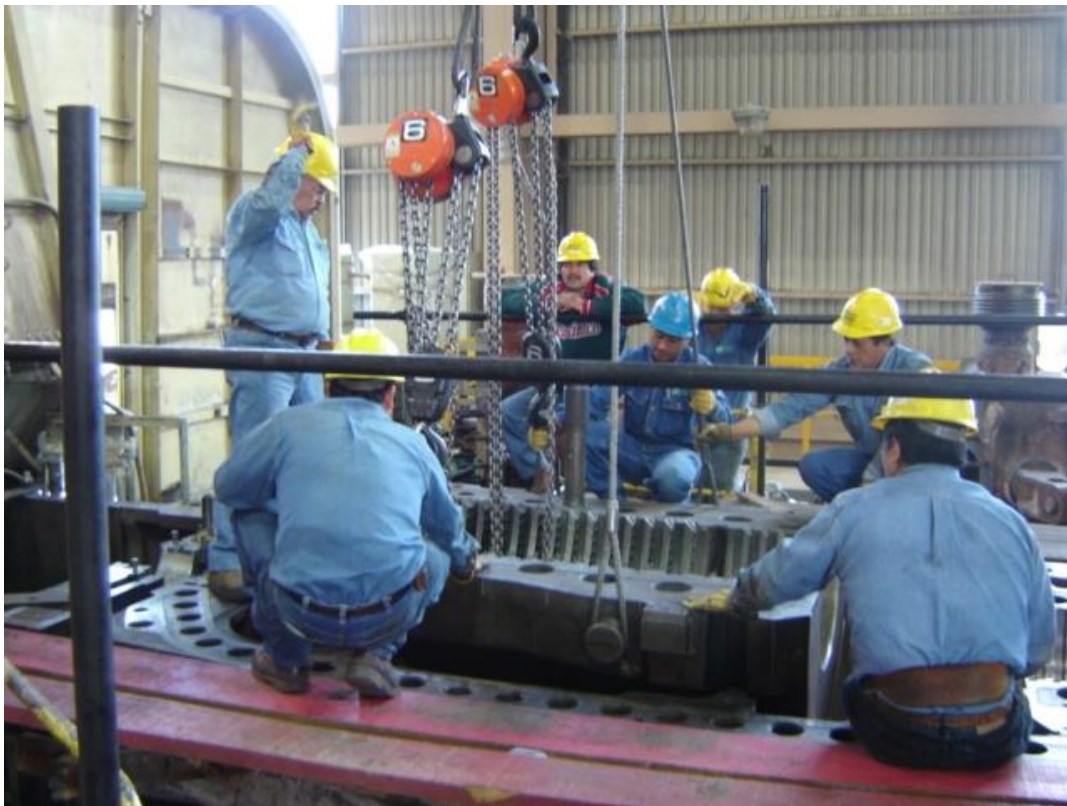
Figura 4.74 Montaje de carcasa interna A.P.
