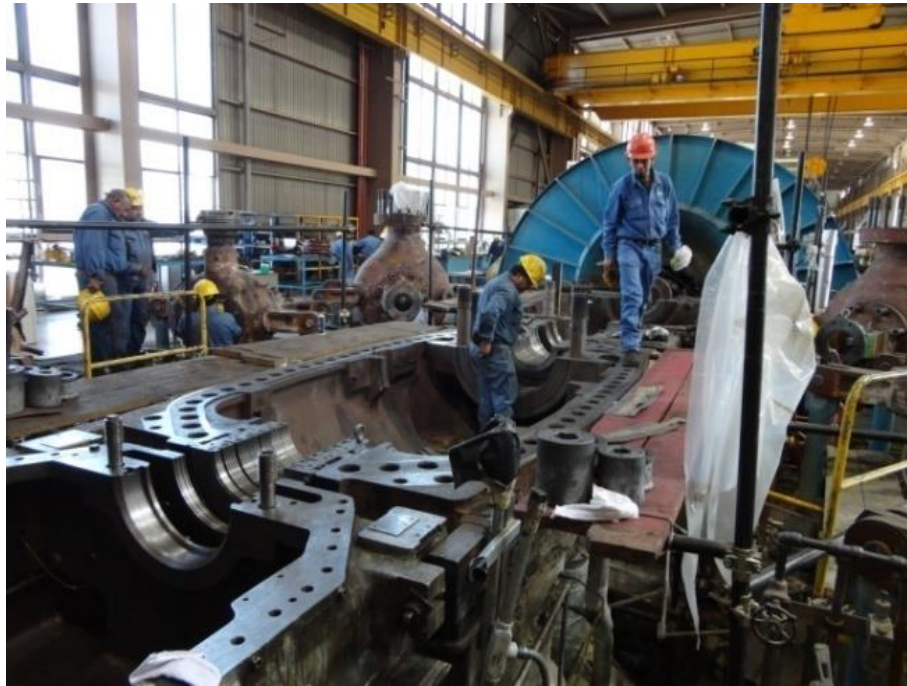
Figura 4.75 Colocando caja de sellos.
