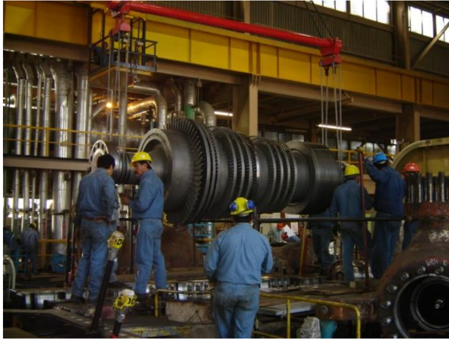
Figura 4.59 Retiro de rotor de presión intermedia.
