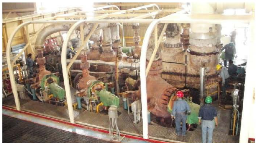
Figura 4.1 Retiro de cubiertas externas.
