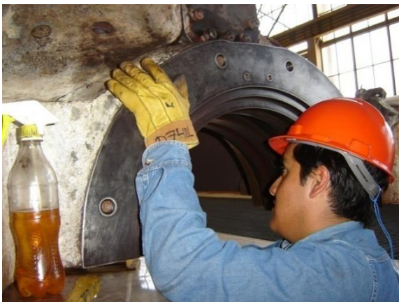
Figura 4.3 Limpieza de las juntas horizontales y verticales.
