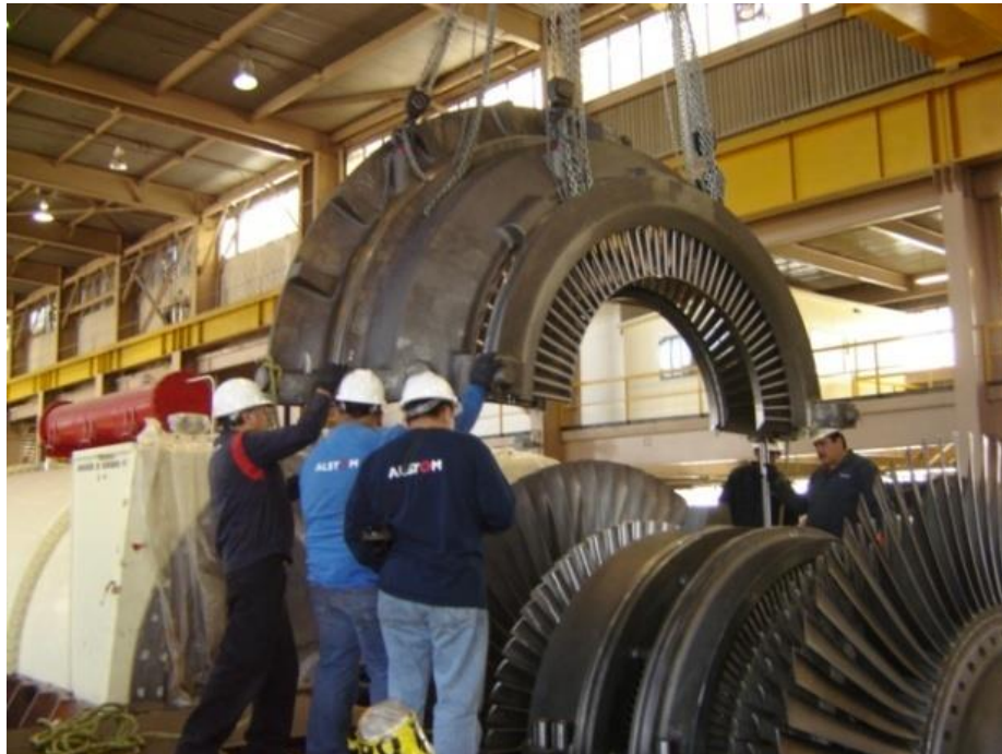
Figura 4.72 Maquinando y colocación de porta alabes por parte de ALSTOM
