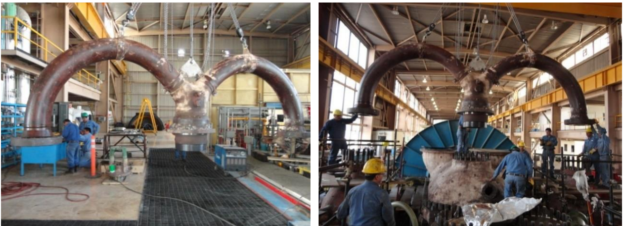
Figura 4.82 Ajuste y verificación de holguras axiales de chumacera núm. 2
