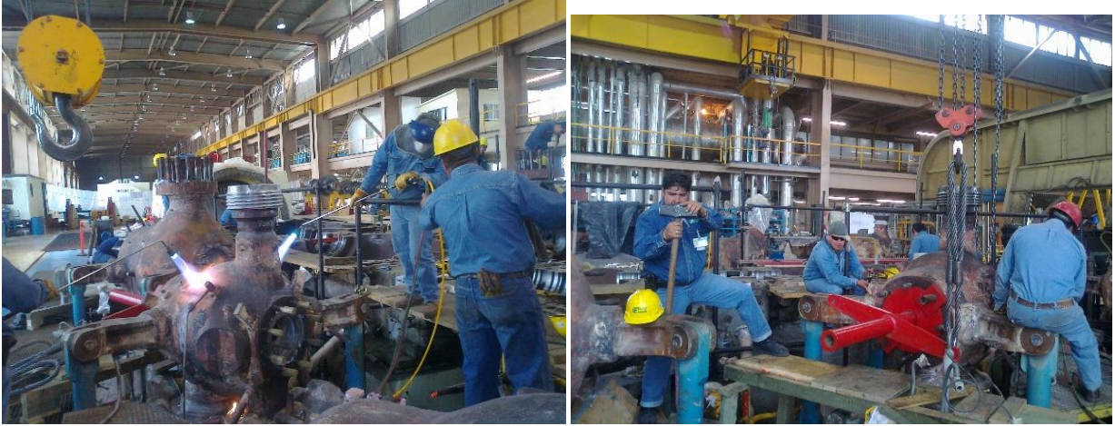
Figura 4.26 Retiro de asientos fijos válvulas de control.
