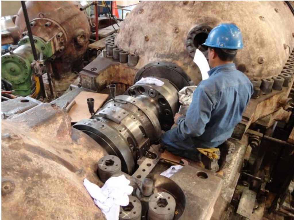
Figura 4.85 Centrado de deflectores en chumacera 2.
