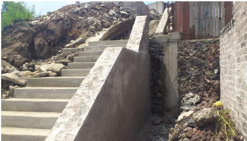
Imagen muro de contención de piedra braza aparente, repellada por un lado. Enfrente barda del vecino que solicito un acabado especial, en obra negra.
