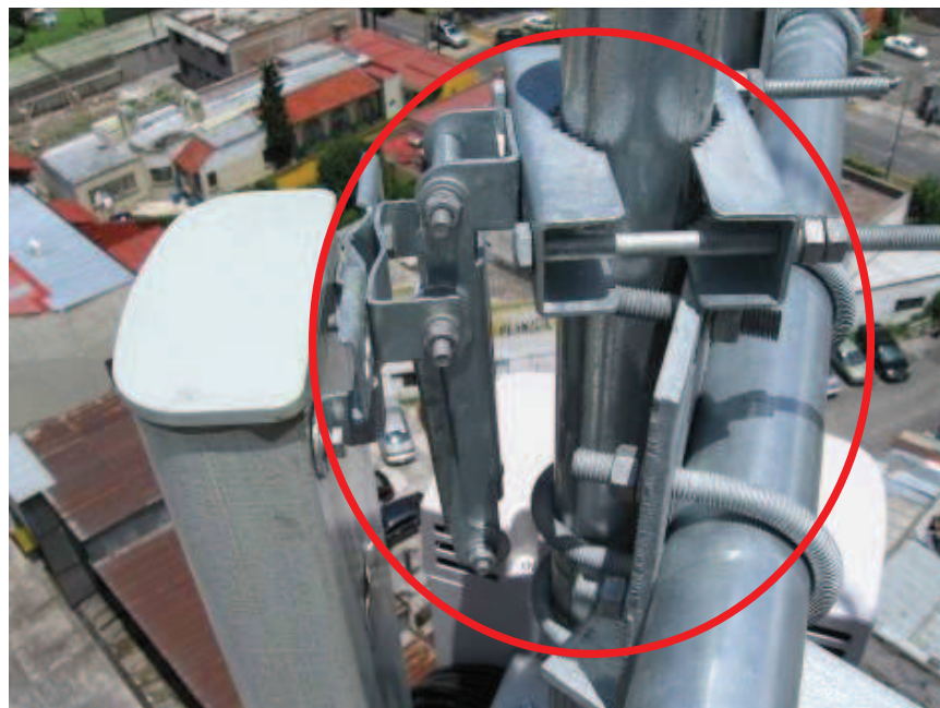
Figura 4.25 Abrazadera superior de la antena.
