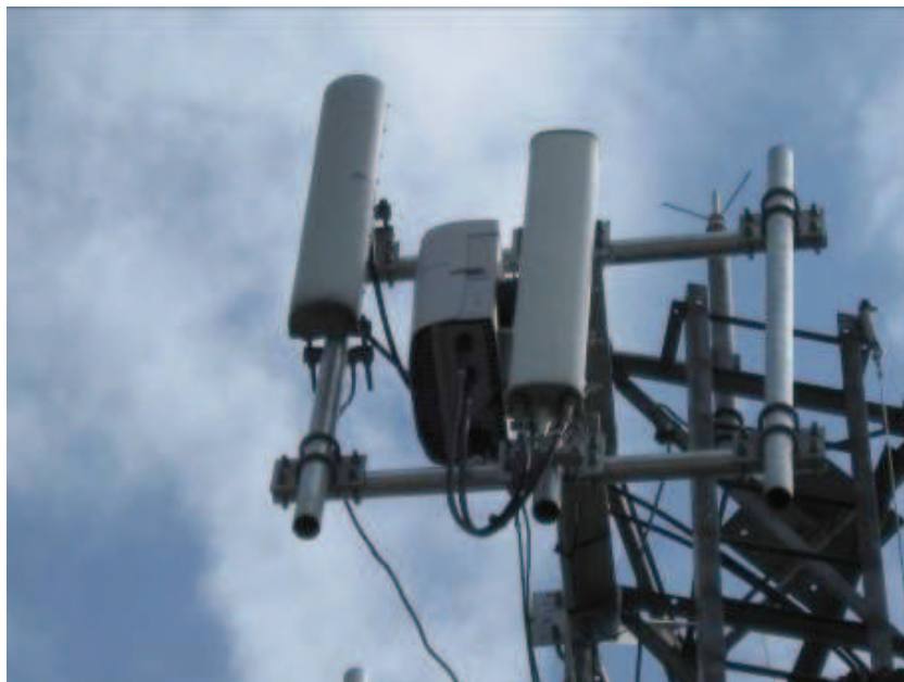
Figura 4.23 Antenas instaladas paralelamente.
