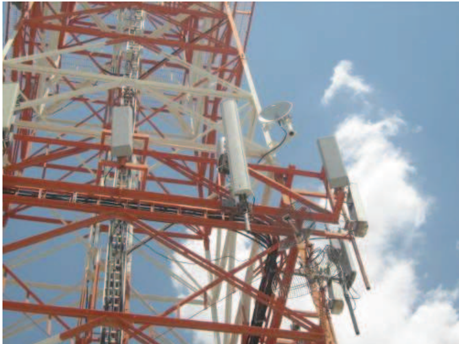
Figura 4.22. Instalación de las antenas en la parte media de la torre.
