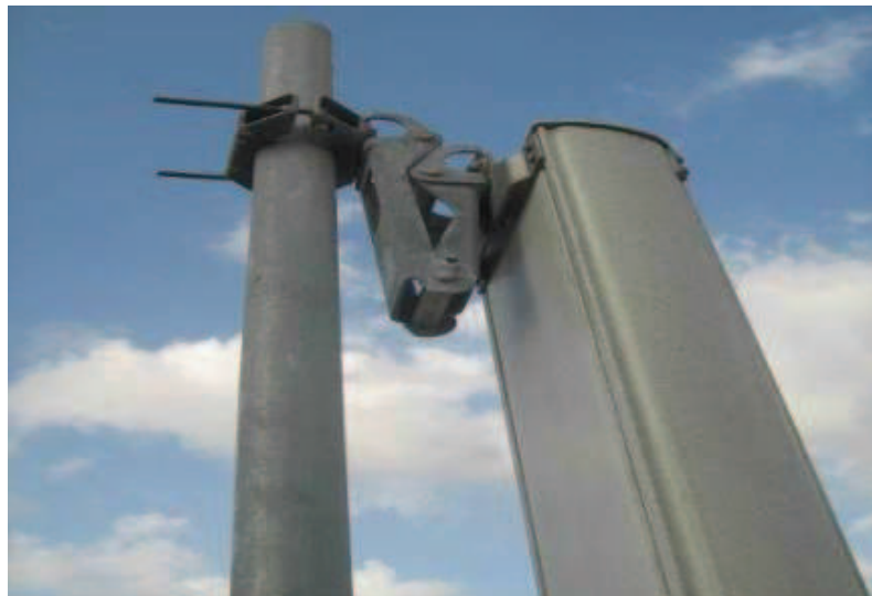
Figura 4.15 Abrazadera superior de la antena para su inclinación.
