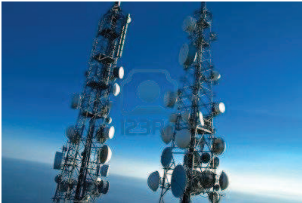
Figura 3.19 Ejemplo de obstrucción por otros equipos.
