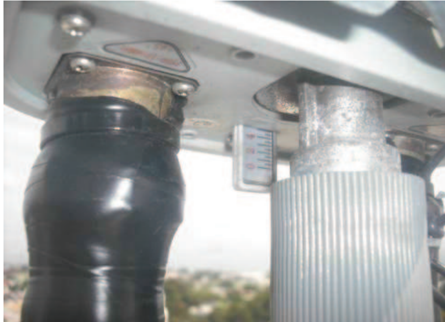
Figura 4.16 Tipo de perilla para dar inclinación a una antena.
