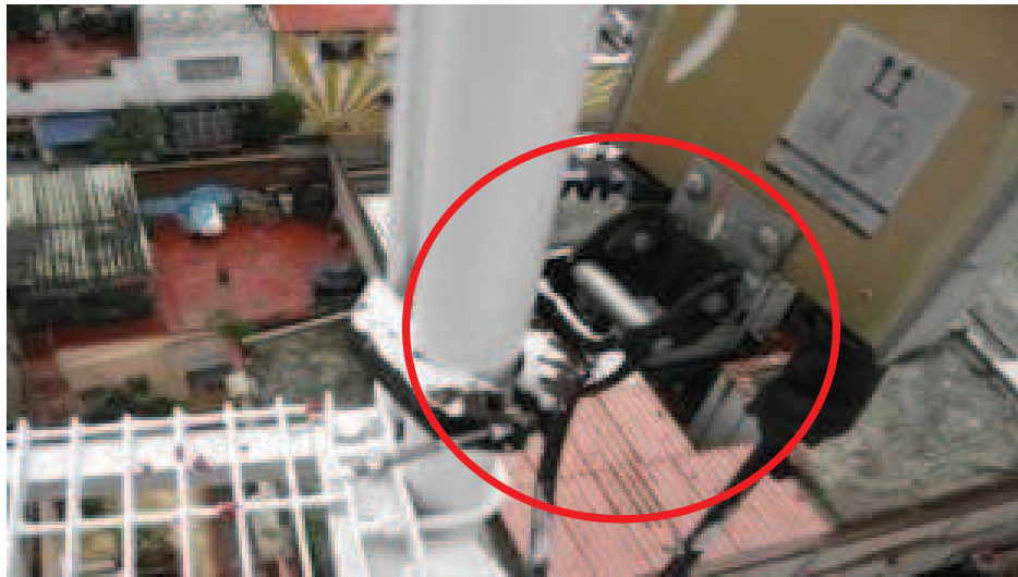
Figura 4.26 Abrazadera inferior de la antena.
