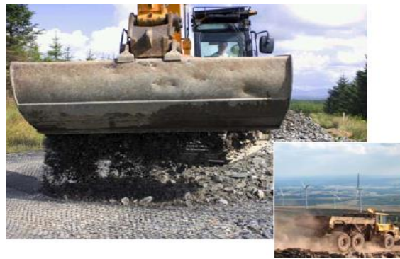
Figura 1.9. Geomalla multiaxiales con piedra site-won, Scotland.
