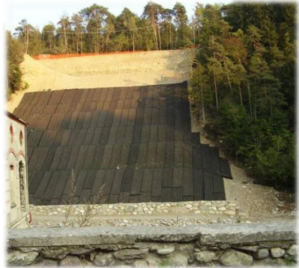
Figura 1.9. Colocación de geomanta; protección contra la erosión.
