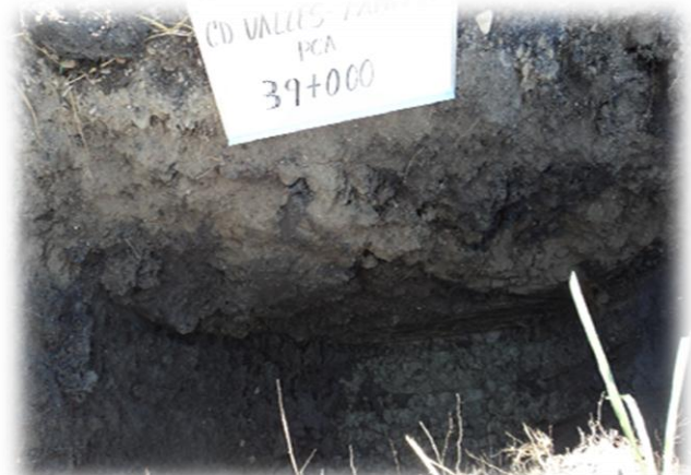
Figura 4.10. Vista "in-situ" del PCA ubicado en el Km 39+000. Fuente: Secretaría de Comunicaciones y Transportes.
