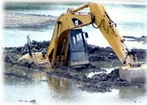
Figura 1.14. Excavadora con dificultades en un suelo saturado.
