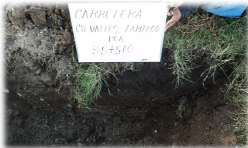
Figura 4.6. Vista "in-situ" del PCA ubicado en el Km 35+500.
