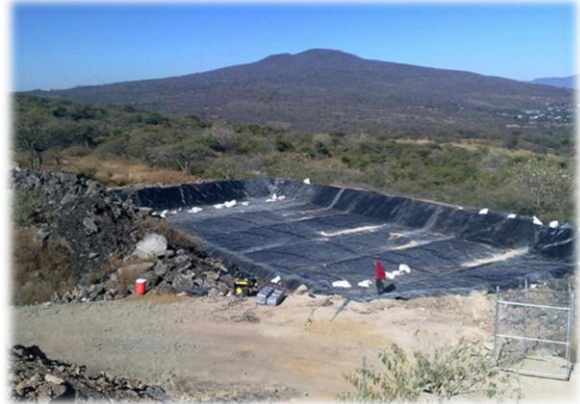
Figura 1.4. Aplicación de geomembrana en un relleno sanitario, Yuriria, Guanajuato.
