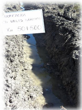
Figura 4.17. Vista "in-situ" del PCA ubicado en el Km 50+500.
