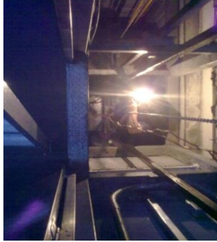
Fijación de los raíles a la soportaría ya colocada.
