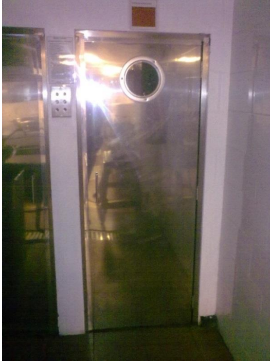
Puertas de piso ya colocadas y pulidas.
