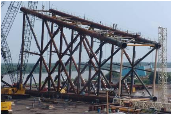
Fig. 2.2.3 (arriba, izq.) Jacket en proceso de fabricación.
