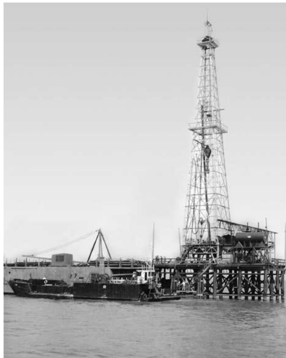
Fig. 1.2.2- Primer plataforma marina costa afuera.
