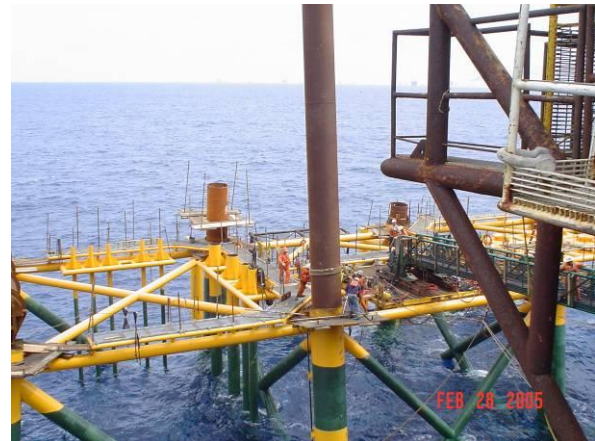
Fig. 2.1.9 Hincado de pilotes en la ubicación final de la plataforma.
