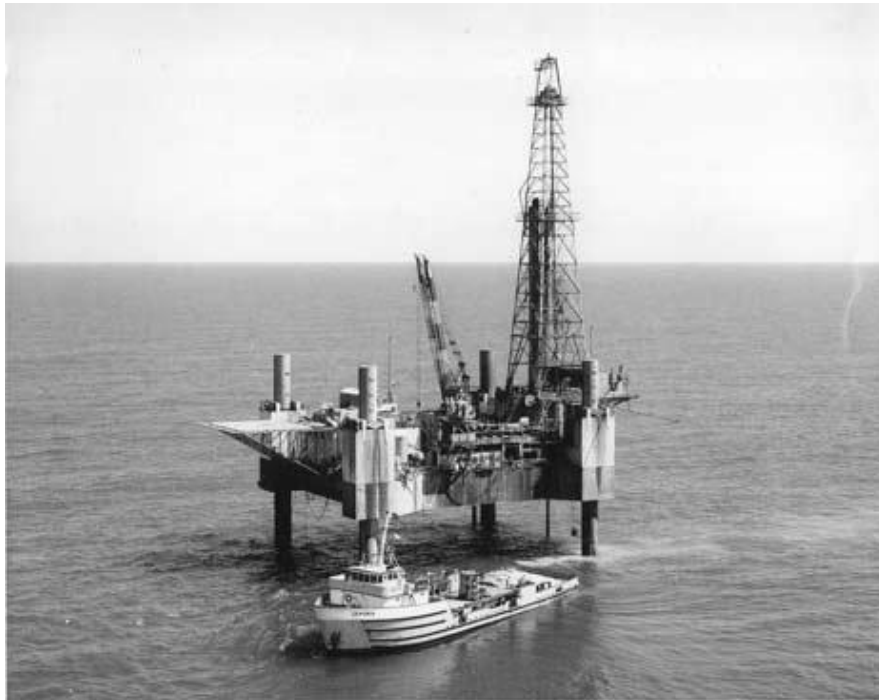
Fig. 1.2.3- Plataforma tipo Jackup “Vinegaroon” de Petrobras, 1971.
