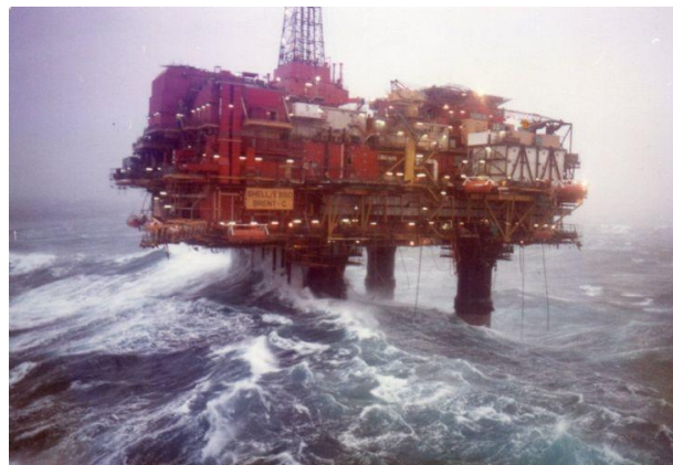
Fig. 4.5.1- Oleaje en condición de tormenta afectando a una plataforma en sitio.
