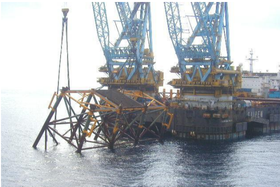
Fig. 2.2.15 (arriba, izq.) Jacket “botada” al mar.
