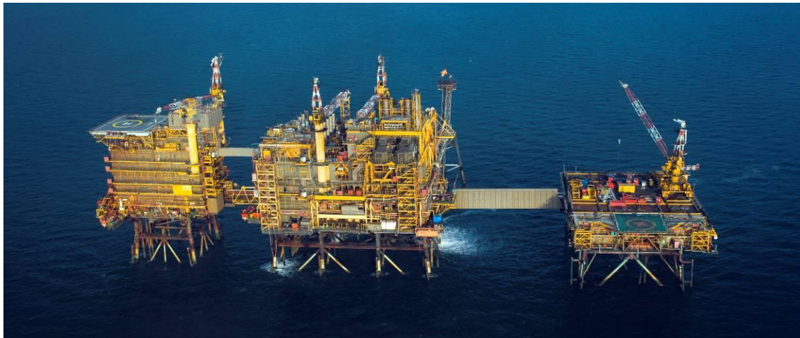
Fig. 1.2.1- Conjunto de plataformas típicas de acero.
