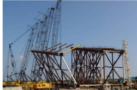
Fig. 2.2.3 (arriba, izq.) Jacket en proceso de fabricación.
