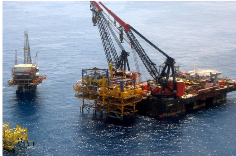
Fig. 2.2.23.- Parte final de la instalación de la superestructura
