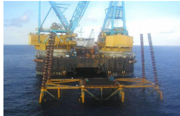
Fig. 2.2.19 (abajo, der) Subestructura fija, nótese los pilotes en las piernas.
