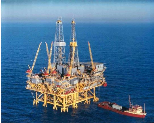
Fig. 2.1.2- Cubierta de plataforma Bullwinkle en el Golfo de México.
