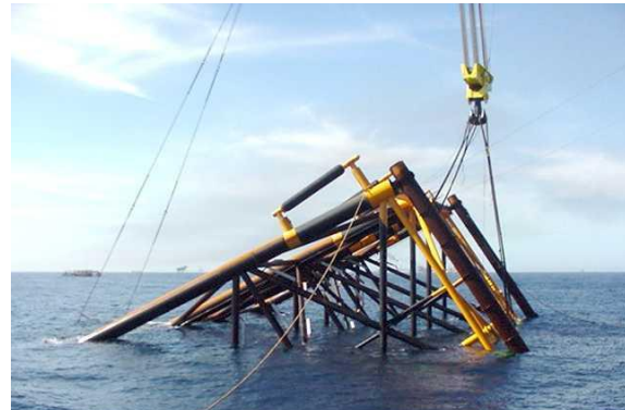
Fig. 2.2.15 (arriba, izq.) Jacket “botada” al mar.
