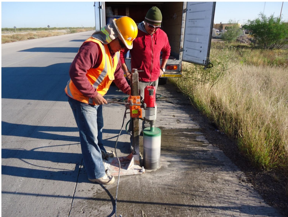
Figura 9. Equipo de alto rendimiento en sondeos
