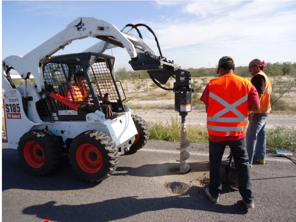
Figura 8. Equipo de alto rendimiento en sondeos
