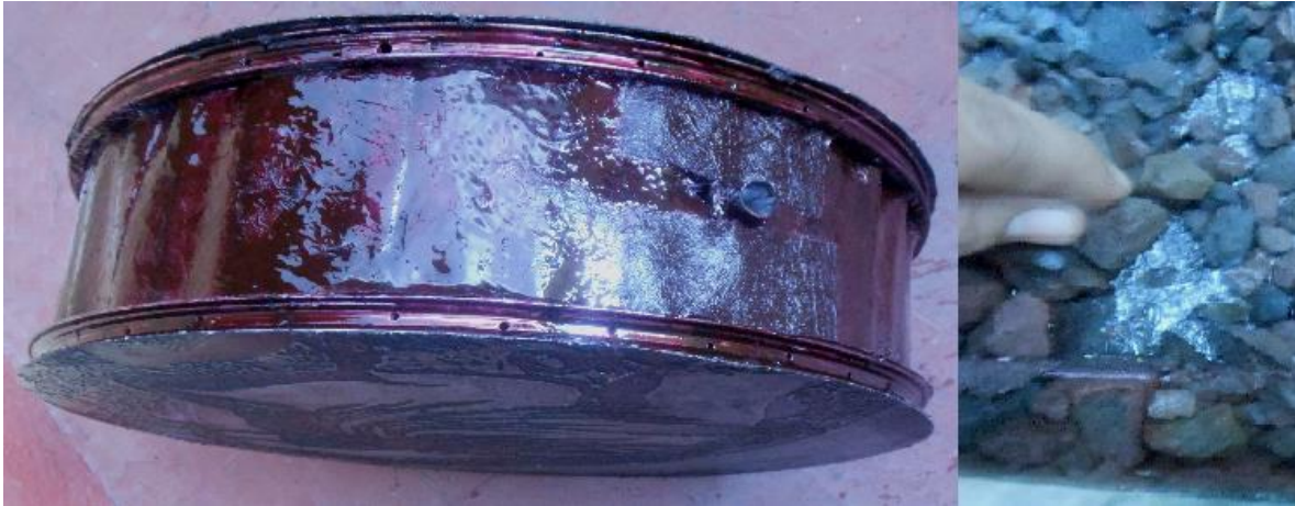
Imagen del perímetro de la base con revestimiento de resina y colocación de la piedra.
