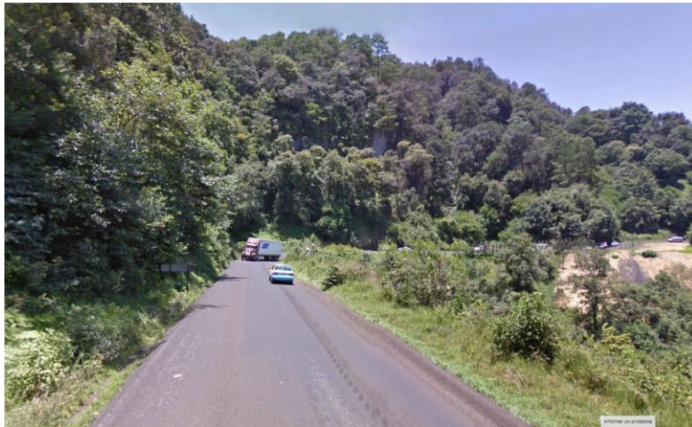
Figura 3.12: Km. 5 de la Carretera Teziutlán-Perote (Fuente: Google Earth, 2009)
