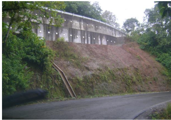
Figura 3.69: Muro de contención en Km. 4 del Ramal a Hueytamalco.
