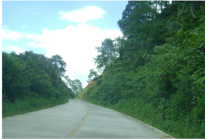
Figura 3.28: Tramo en buen estado Km. 15.
