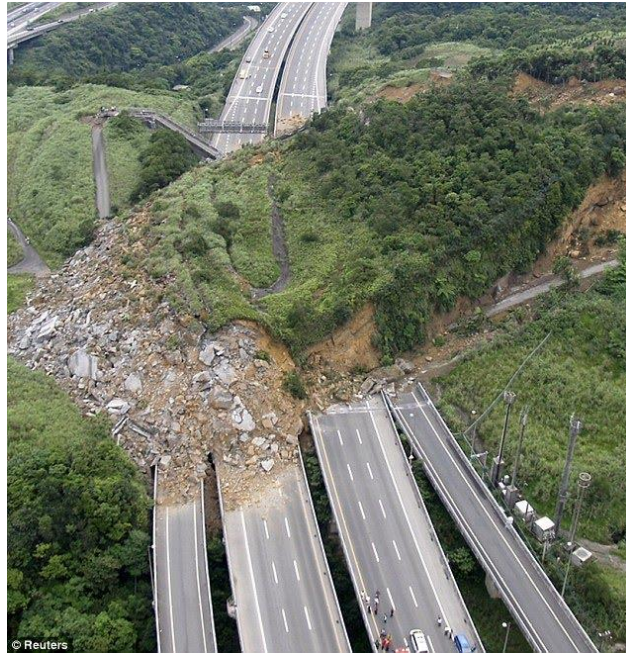
Figura 1.9: Deslizamiento ocurrido en abril de 2010 en Taiwán. Fuente: ( www.landslideblog.org )
