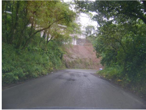
Figura 3.25: Muros de contención en la carretera a Hueytamalco (Foto: Matilde Cruz).
