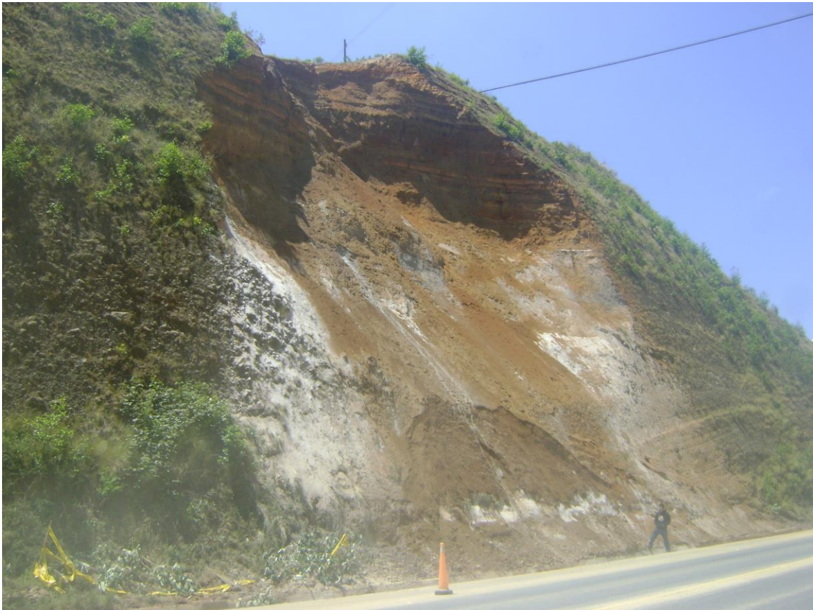
Figura 3:1 Deslizamiento en el kilómetro 115 de la Autopista Puebla-Teziutlán (Foto: Alejandro Galindo).
