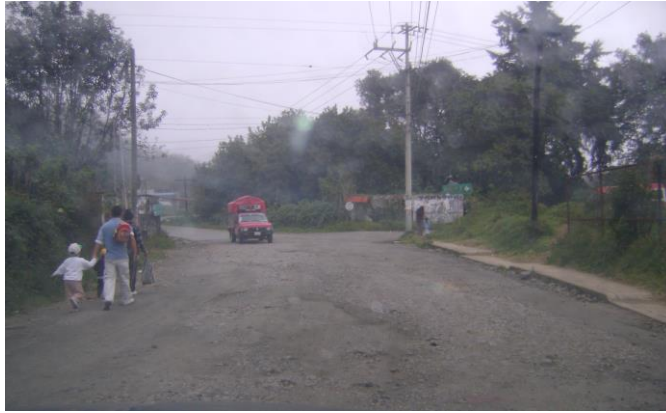
Figura 3.23: Vialidad en estado de conservación muy malo (Foto: Matilde Cruz).
