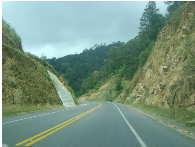
Figura 3.7: Autopista Puebla-Teziutlán a la altura del municipio de Chignautla, Km.130.
