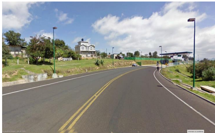
Figura 3.21: Camino municipal de Zaragoza (Fuente: Google Earth, 2009).
