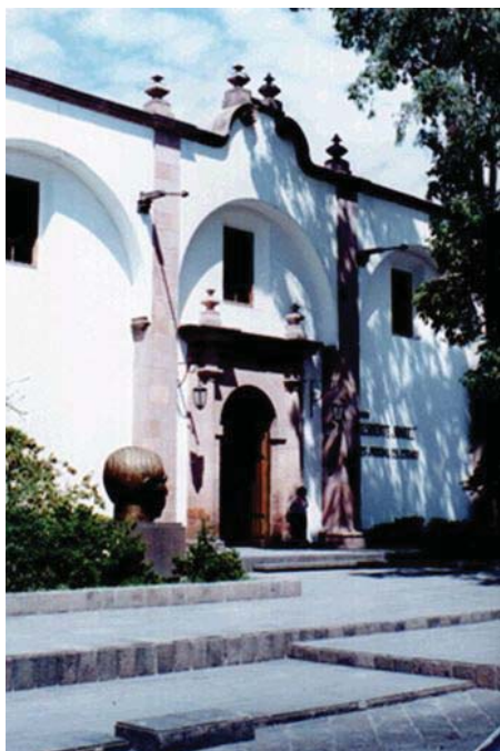
Frente de la capilla antigua y parte del edificio que actualmente la flanquea. 1071 Se observa cómo la elevación del piso afectó a las proporciones del edificio.
