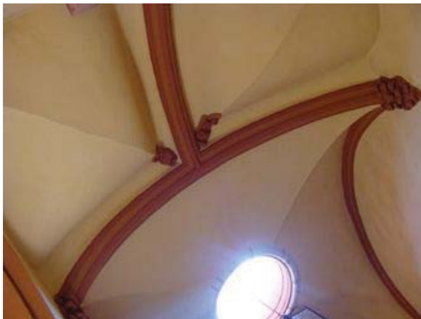
Dos de las tres bóvedas que cubren el cubo de la escalera. Una alabeada y otra de arista con linternilla. A continuación de ésta última hay otra alabeada. 753
