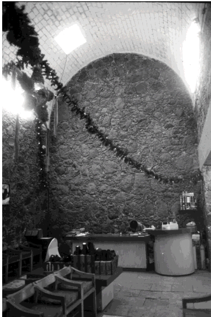
Interior de una de las trojes que ahora alberga una zapatería. Esquina entre Hidalgo y Julián de los Reyes, foto de Arnoldo Kaiser, 1994. 917 Se aprecia la cuidadosa alineación del aparejo en la bóveda.
