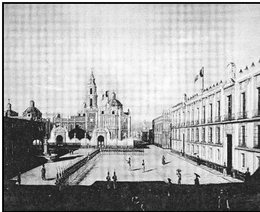
Plaza de Santo Domingo. Al lado derecho la Aduana. Pedro Gualdi. 1841. INAH. 320 Se aprecia el aspecto que cobró la fachada regida por sus dos portadas.
