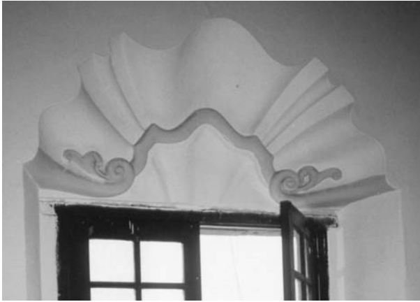
Capialzado rococó en una de las salas del primer piso. Todos son diferentes. Se observa cómo la pintura rosada actual empasta las formas. 762
