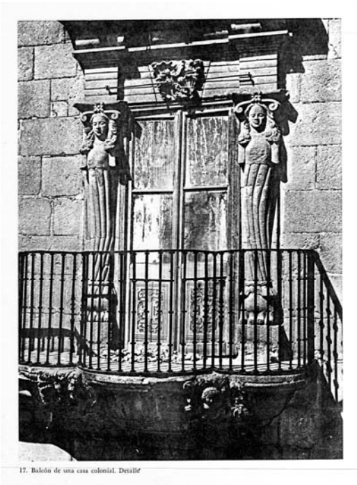
17. Balcón de una casa colonial. Detalle
