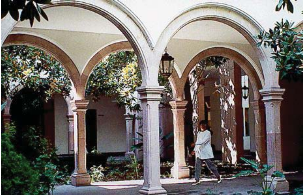
Planta baja del edificio actual. Se aprecian los pilares que sustentan los dos patios que ahora existen; algunos quizá conservan partes originales.
