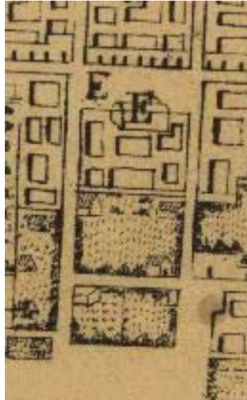
Plan Horizontal [sic] de la ciudad de San Luis Potosí con todos sus pueblos, y barrios extractado por D. Juan Mariano de Vildósola del que formó D. Manuel de Buraça, Año de 1777. (Detalle) La Casa de las Recogidas está marcado con la letra “E”.
