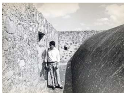
Exhacienda jesuita de la Parada. S. L.P. Fachada del edificio con trojes contiguas cubiertas con bóvedas de cañón corrido. 873
