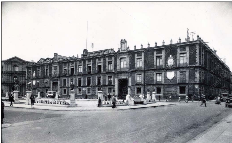
Fachada de la Real Aduana. Los seis balcones del lado derecho de la fachada más los cuatro sobre la calle lateral pertenecieron a la casa que habitó el superintendente interino Felipe Cleere. 551
