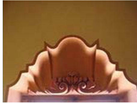
Capialzado rococó en una de las salas del primer piso. Todos son diferentes. Se observa cómo la pintura rosada actual empasta las formas. 762
