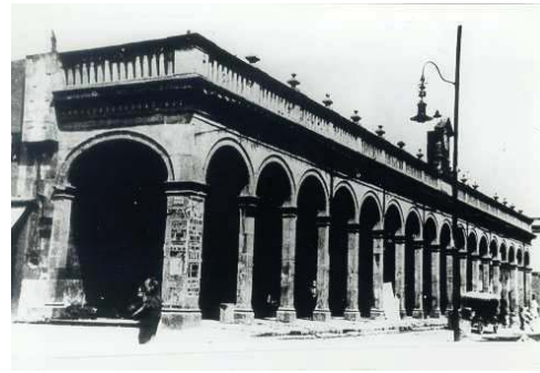
De los 17 arcos, los del frente son más elevados que los colaterales y presentan el mismo peralte que los de la Real Caja. 901
