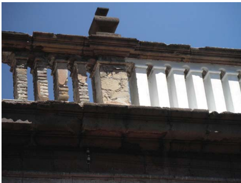
Almenas en proceso de restauración. 942
