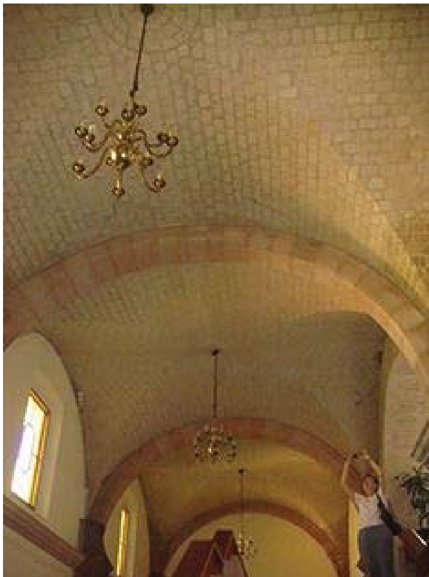
Interior de la Capilla Se observa la perfección de la plementería de las bóvedas de arista. Se alcanza a ver parte de una escalea que se añadió en el siglo XX. 1085
