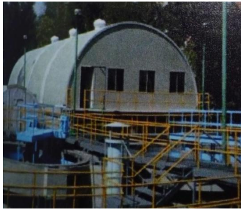
Figura 3.6 – Cubierta del sistema BRM de la PTARCA.
