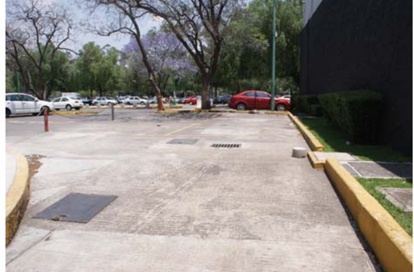
Figura B12.- Se puede observar los 3 registros del pozo.
