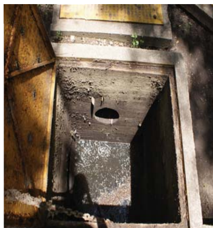
Figura B19.- Trampa de sólidos después de una precipitación
