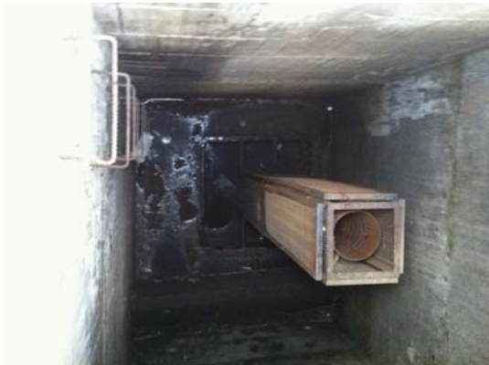
Figura B13.- Vista interior del pozo de Economía, obsérvese que debido a la facilidad de flujo, el pozo no contiene agua.
