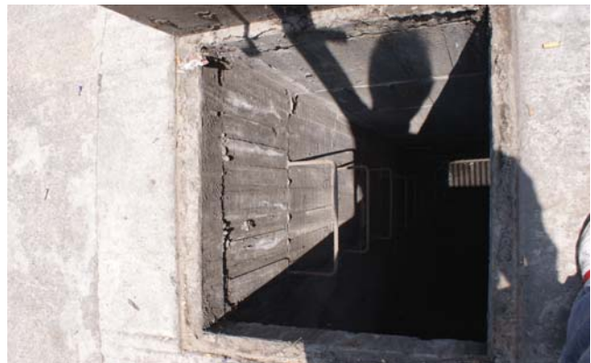
Figura B14.- Escalera de descenso.
