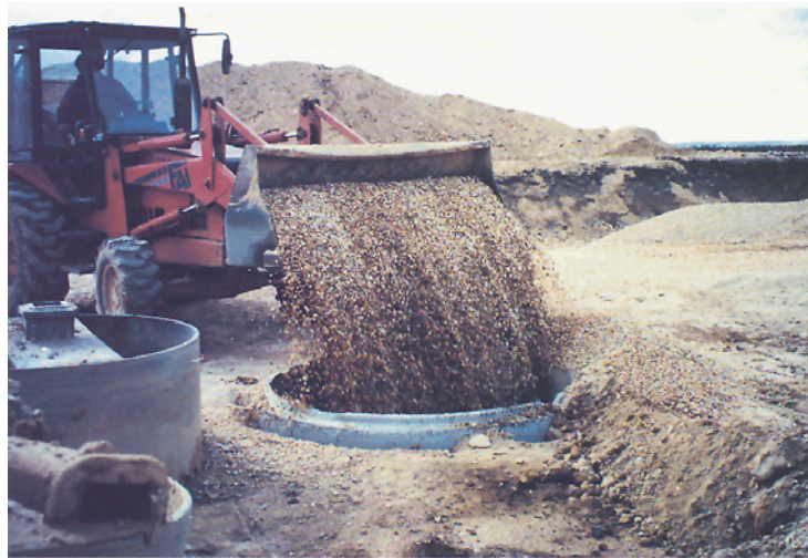
Figura 2.7.- Construcción de una trinchera de infiltración
