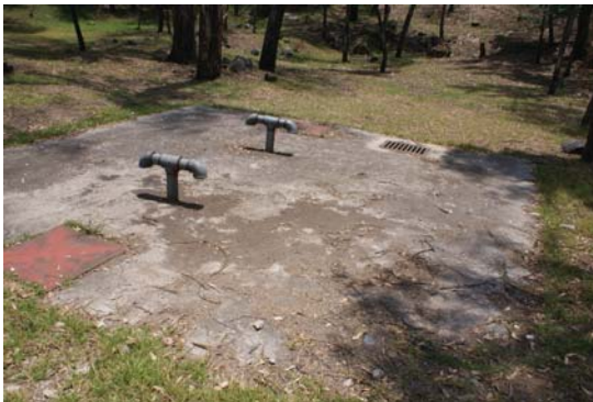
Figura B27.- Cisterna de almacenamiento de agua pluvial para después infiltrarse al acuífero.
