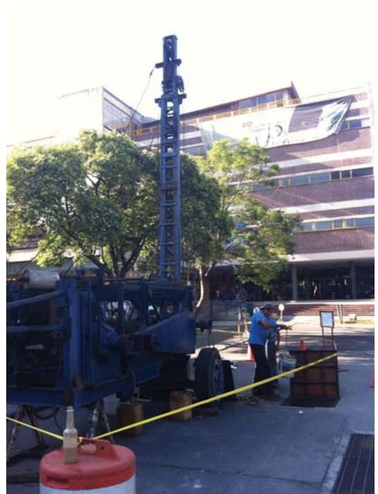
Figura B25.- El Pozo de Química durante el tiempo de limpieza
