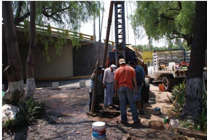
(a) Uso de martinete y escobillas de alambre para la limpieza del ademe
