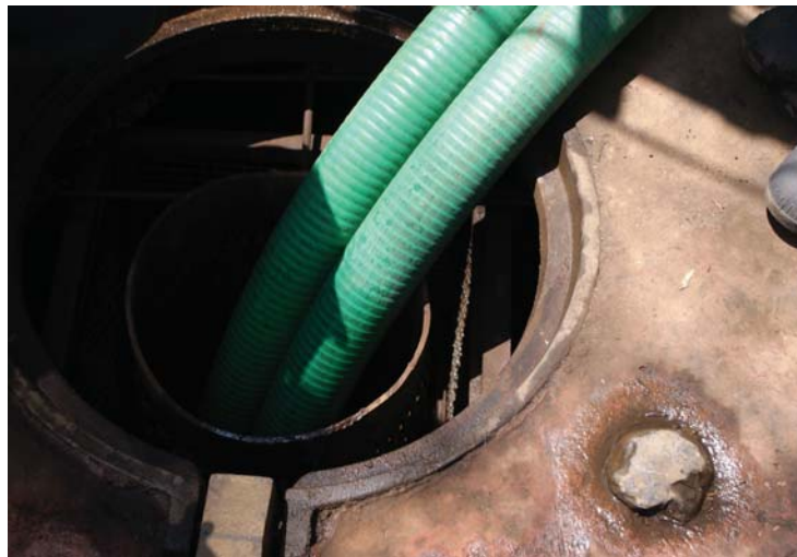
(b) Bombeo del agua para determinar si el ademe y el pozo han quedado limpios
