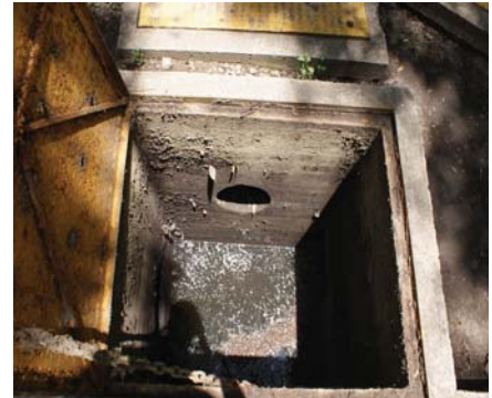
Figura 4.9.- Trampa para retener sólidos
