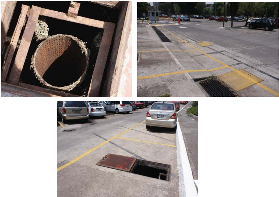
Figura 4.3.- Ademe y proceso de infiltración Pozo de absorción de “Filosofía y Letras”, Abril 2012
