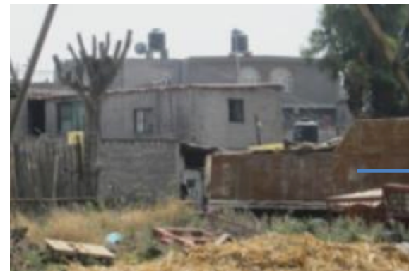
CONSTRUCCION DE BLOCK DE CEMENTO Y LAMINA.
