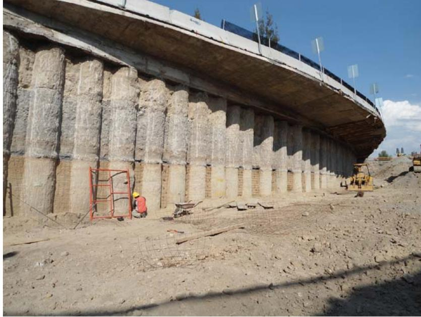
**Figura 2.19** Rugosidad en pilas perforadas en rellenos, lahares y tobas (Foto cortesía de Ing. Raúl Verduzco)
