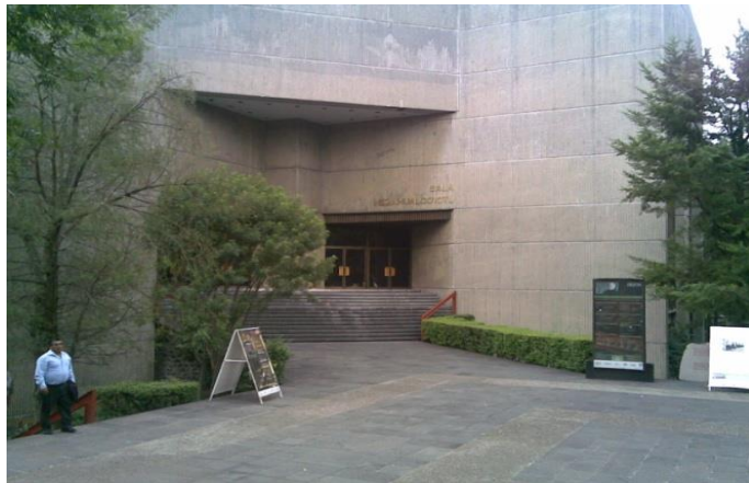
C.C.U. Sala Netzahualcóyotl, acceso principal
