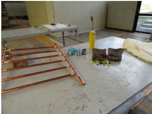
Gráfico A.3.3 Materiales y equipo de seguridad para el soldado de la tubería
