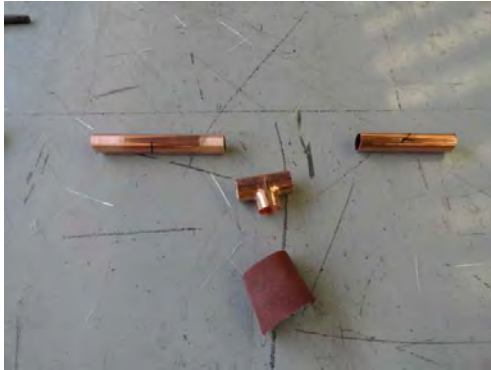
Gráfico A.3.1 Seccionado y lijado de la tubería de cobre
