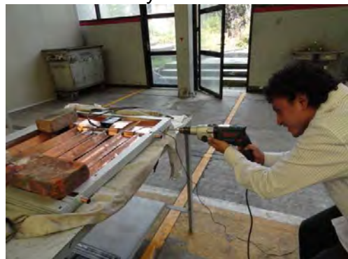
Gráfico A.3.10 Abocardado del marco para la entrada y salida de cables
