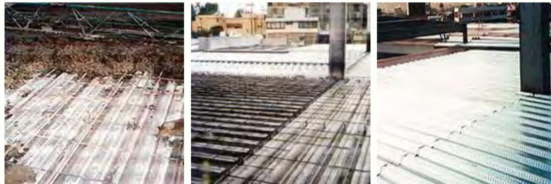
Imágenes de la losacero en una estructura de acero
