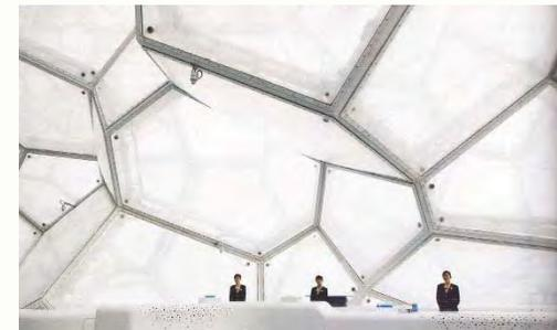
*La estructura es aparente al interior y compone muros y cubierta sin revestimientos*
