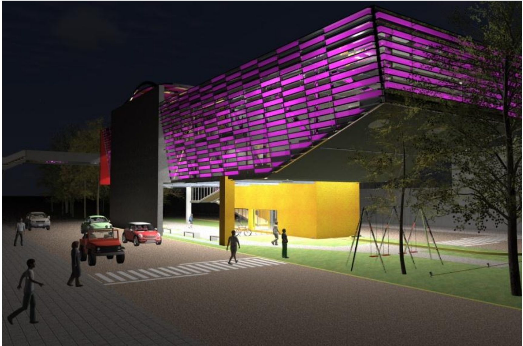
Vista Poniente del Centro desde Eje 10 Pedro Enríquez Ureña : Acceso Principal (Noche)
