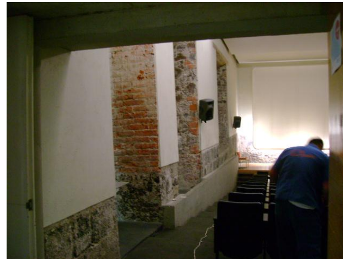
Mirada hacia el interior del auditorio cerrado.
