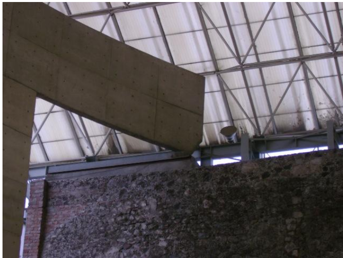
Detalle de unión escenario-muro perimetral.
