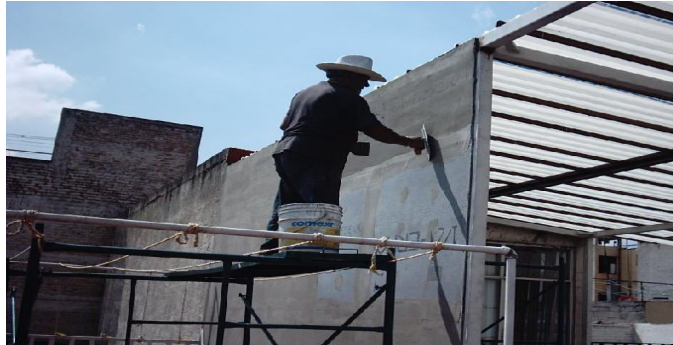
Figura 73 Aplicación de placa durock y posteriormente cemento [38].
