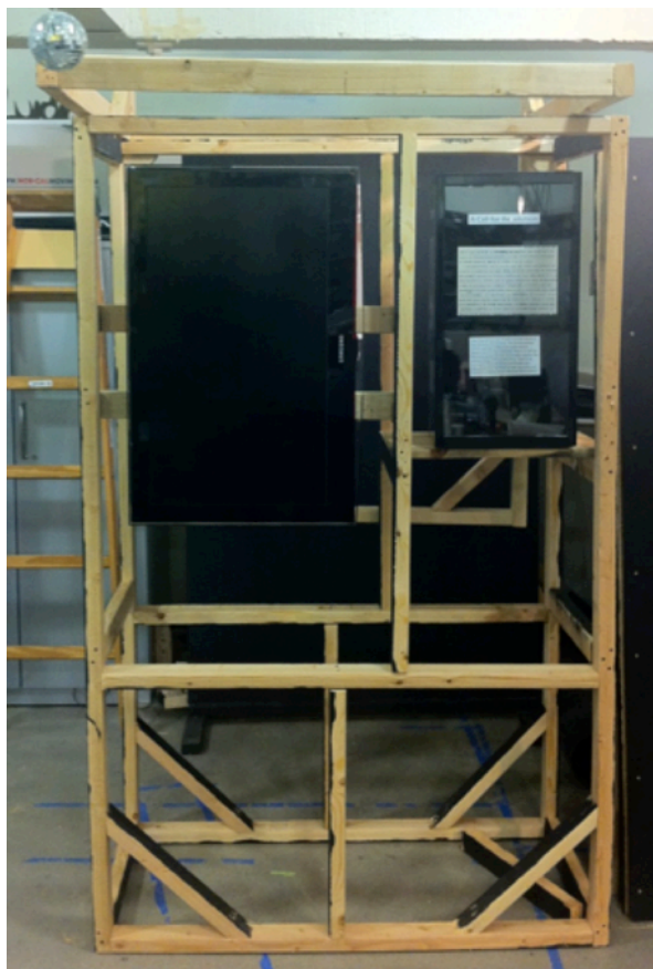
Imagen 13: Marco del prototipo del muro de madera.
