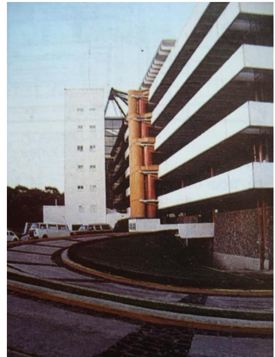
Vista edificio principal.
