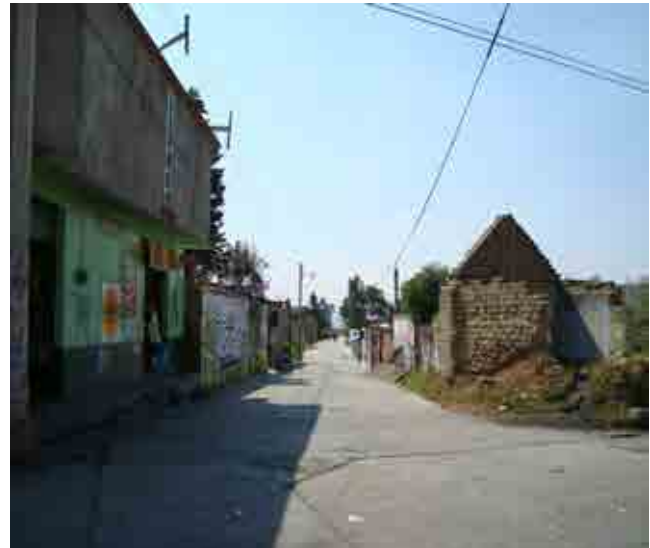
Contaminación visual por redes de cables y anuncios en paredes.
