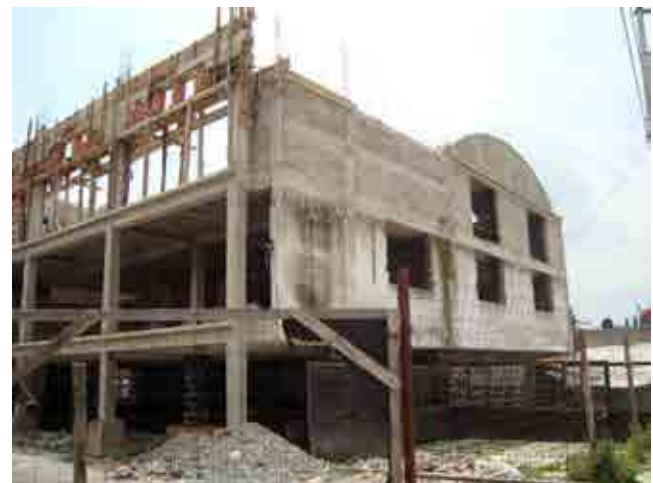
Edificio en remodelación del Comisariado Ejidal. Este edificio se encuentra en la vieja plaza del pueblo y frente a la Iglesia.
