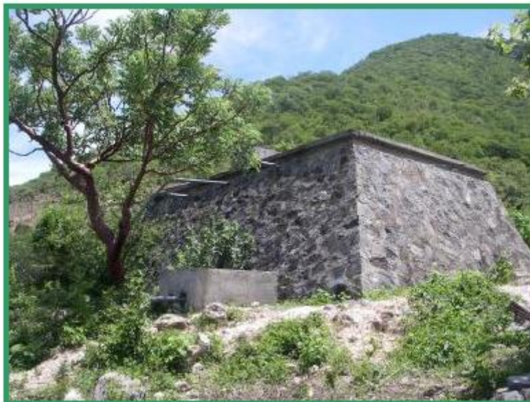
Nuevo tanque de regulación localizado en una parte alta de la Localidad, con el cual se pretende abastecer a un mayor número de habitantes.
