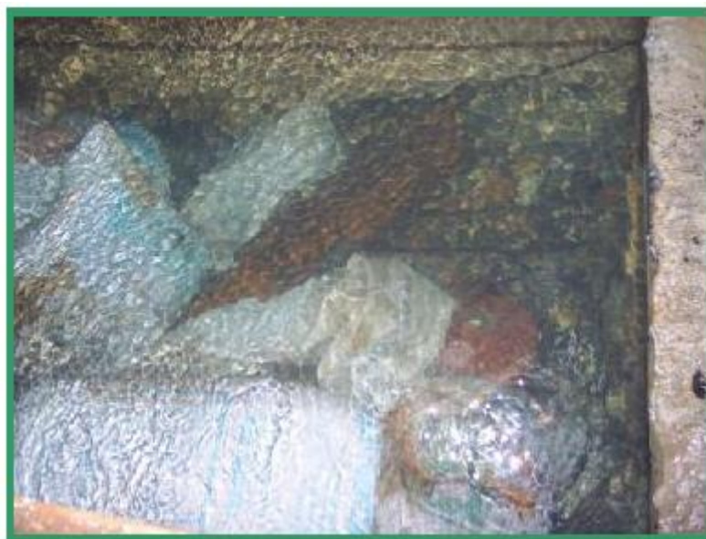
Interior de la Caja de Captación del Manantial.
