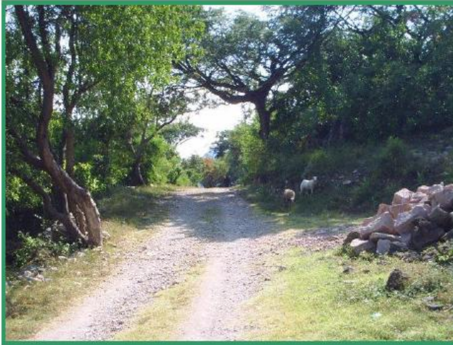
Intersección entre el camino a la fuente de agua y el camino a Chichicasco El Viejo, camino revestido sin problemas para realizar la excavación de la zanja.
