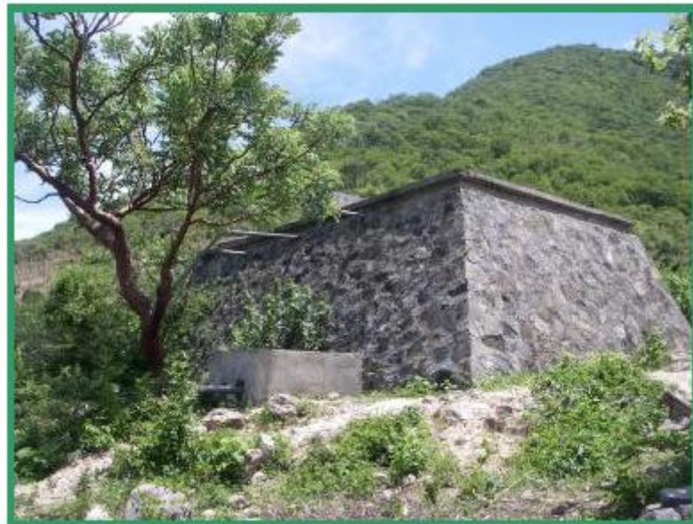
Nuevo tanque de regulación localizado en una parte alta de la localidad, construido por los habitantes del municipio.
