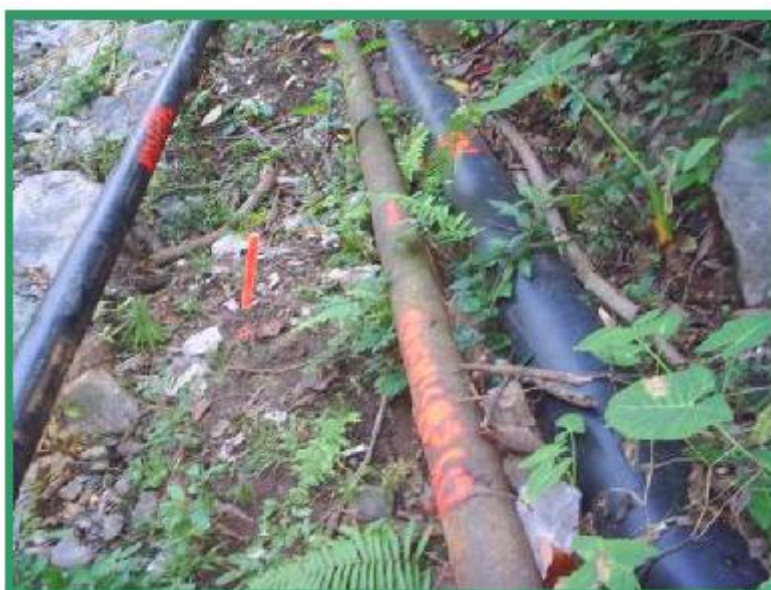
Línea de Conducción a la Localidad.
