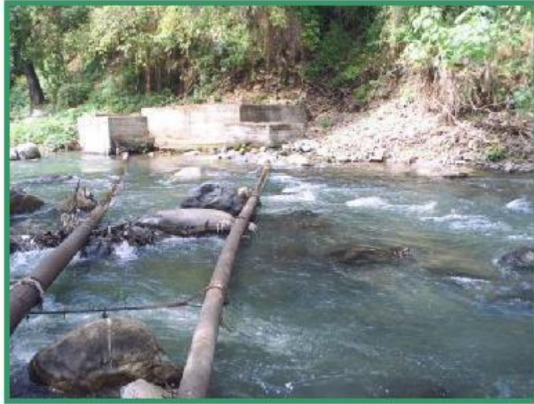
Cruce de la Línea de Captación del Manantial con el río Chalma.
