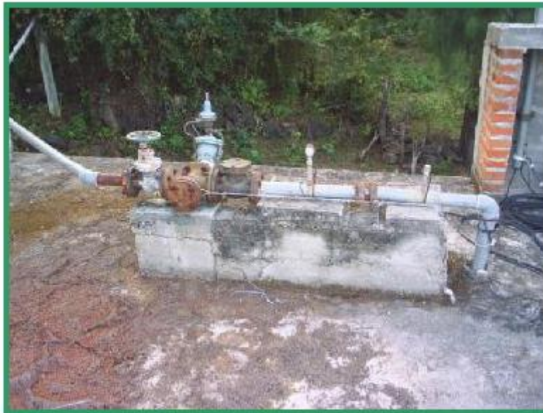
Equipamiento para el Rebombeo de Agua a partir del Tanque de Regulación.
