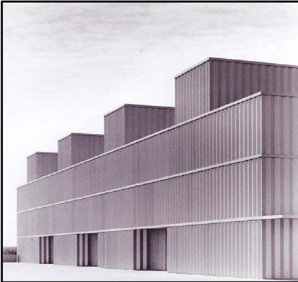
Se constituye por naves paralelas sin aperturas al exterior a excepción de las puertas de acceso, naves que se iluminan natural y artificialmente a través de la cubierta. Su imagen exterior resulta de la composición continua de alzados mediante tres niveles de bandejas verticales de aluminio anodizado, intercaladas entre bandas horizontales de concreto.
