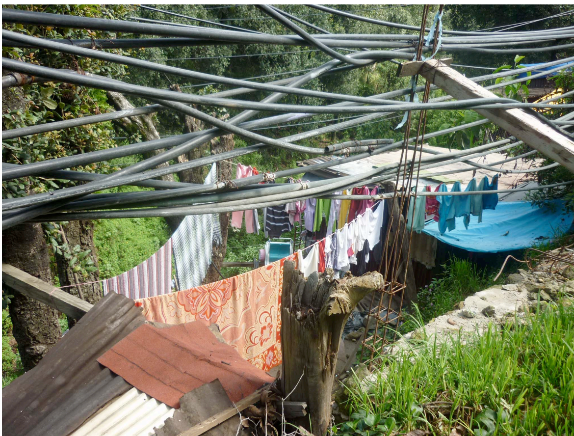
Foto 3: En la imagen las mangueras que se aprecian colgadas fuera de esta vivienda están conectadas con el manantial, la principal forma de abastecimiento de agua en el asentamiento de Tierra Colorada.
