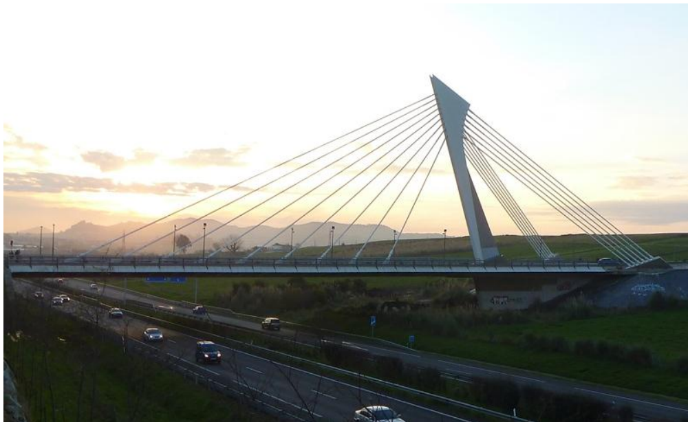
Figura 8 Puente atirantado parque Tecnológico Santander
