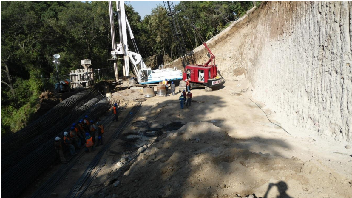
Figura 32 Pilotes en Pila 3
