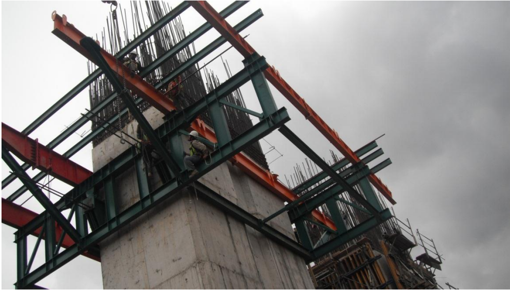
Figura 42 Montaje de estructura de Obra falsa
