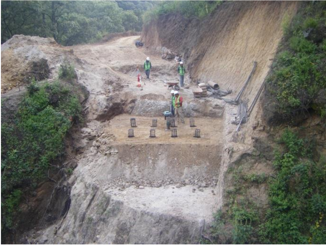
Figura 28 Pilotes dentro del suelo- cemento
