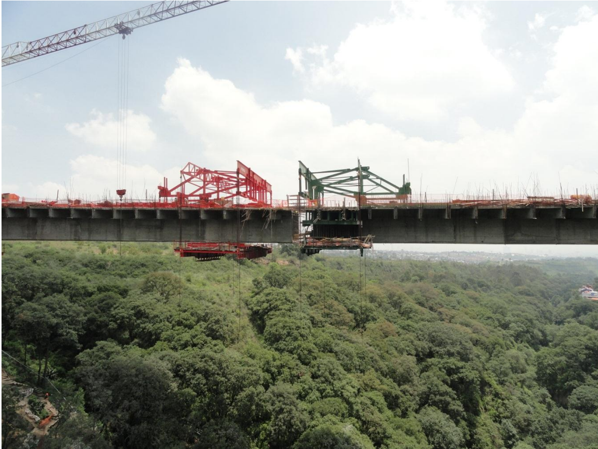
Figura 59 Dovela de cierre claro 2 por colar
