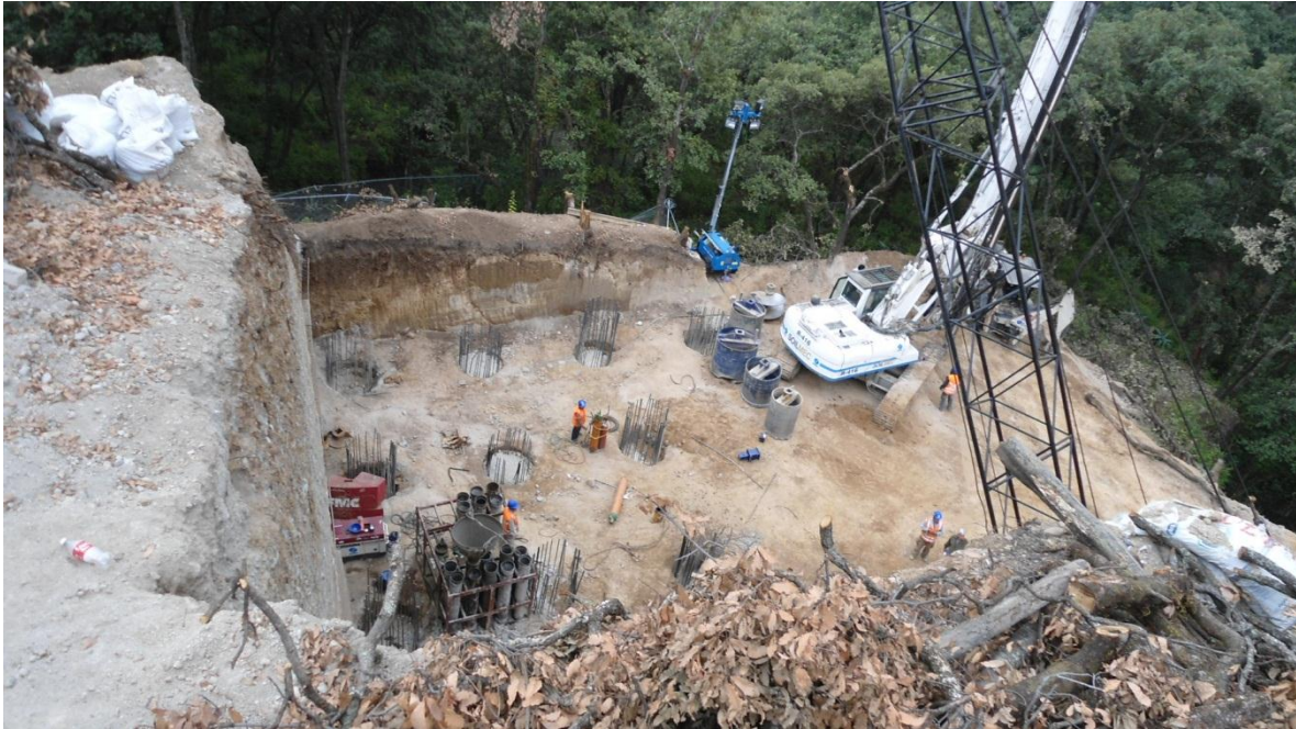
Figura 31 Pilotes en Pila 2
