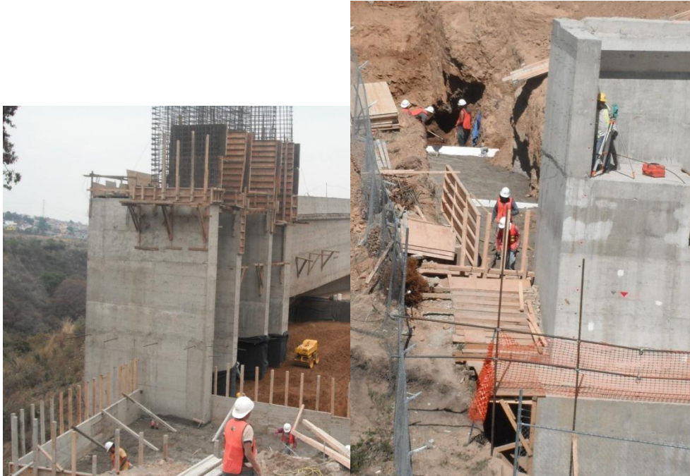
Figura 45 Muros de relleno fluido
