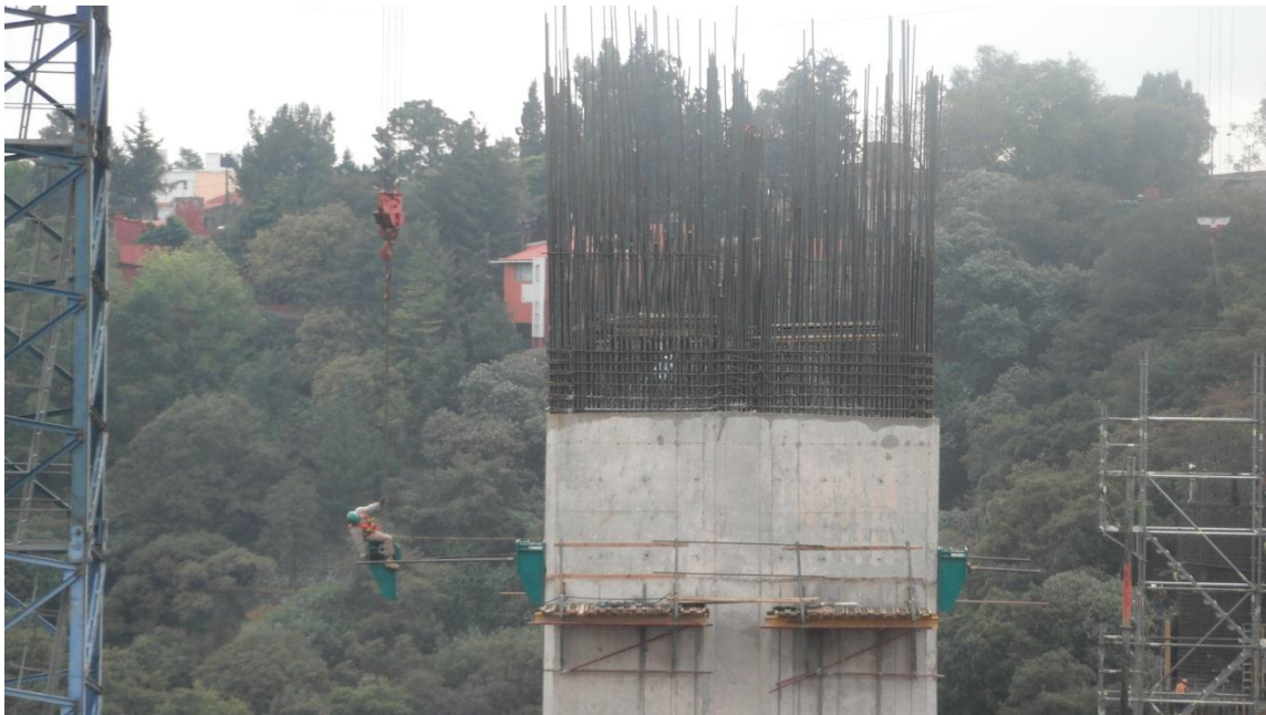
Figura 41 Montaje de Ménsulas
