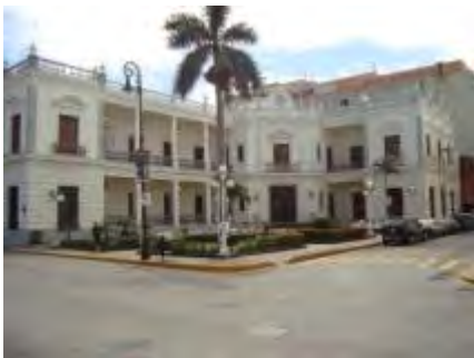
Palacio del Registro Civil
