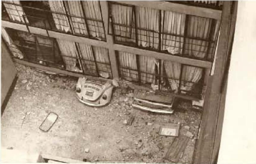
COLAPSO DE LAS COLUMNAS DE PLANTA BAJA EN EDIFICIO DE DEPARTAMENTOS CON FALLA DEL CUERPO DE ESCALERAS.
