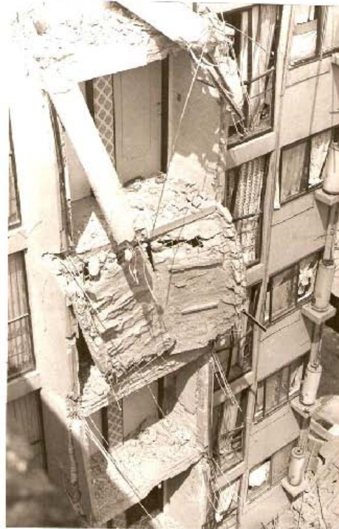
FALLA DEL NÚCLEO DE ESCALERAS DEL EDIFICIO ANTERIOR.
