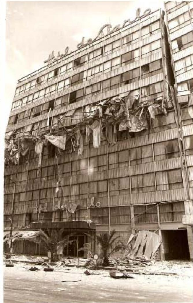
COLAPSO A MEDIA ALTURA DEL EDIFICIO.
