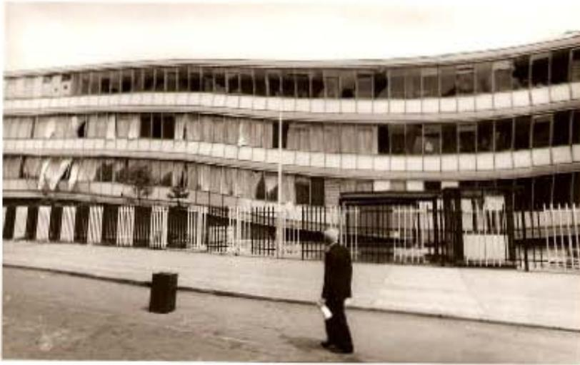
FLEXIÓN LUNA EXCESIVA EN ESTRUCTURA DE ACERO.
