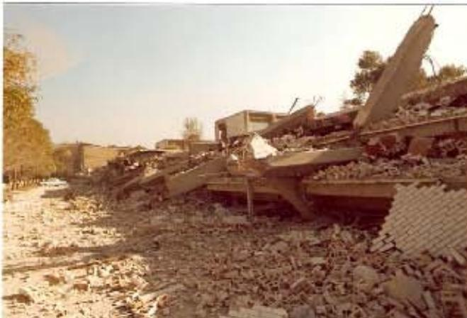
COLAPSO DE EDIFICIO CON ESTRUCTURA DE MARCO, RODEADO DE DOS EDIFICIOS DE MAYOR RIGIDEZ Y ANTIGUEDAD.
